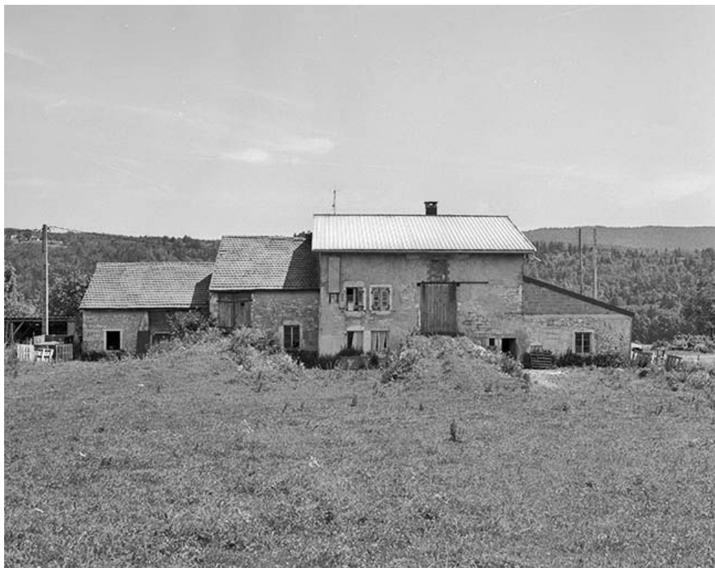
Vue éloignée de la façade postérieure.
