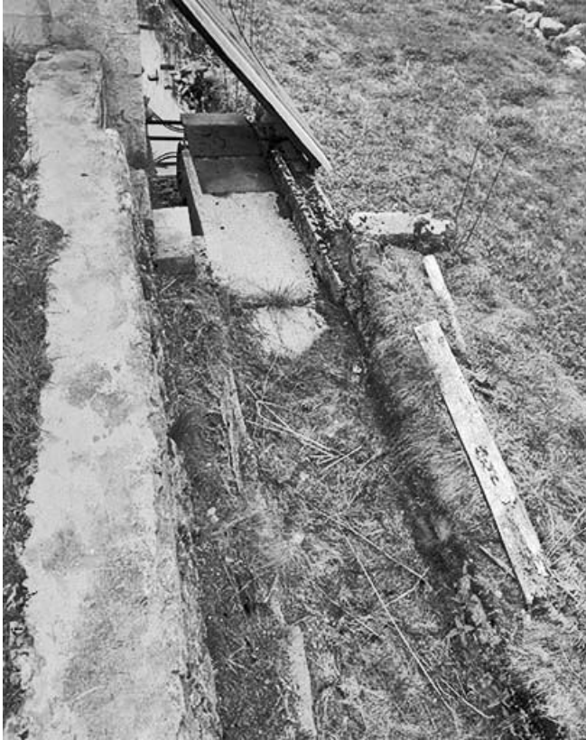
Canal d'amenée d'eau sur la roue ou " arivoir " . 39, Longchaumois, lieudit : les Moulins Piquands
