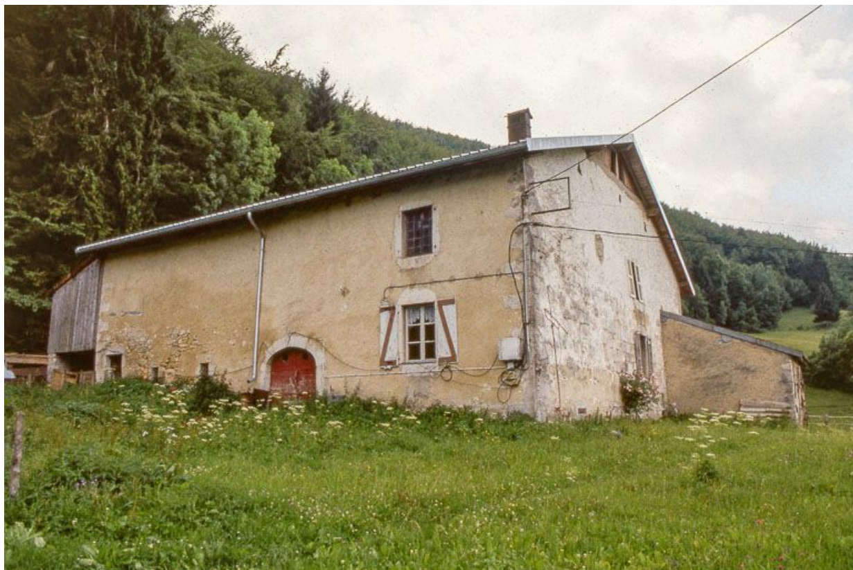
Façade postérieure et face gauche vues de trois quarts.
