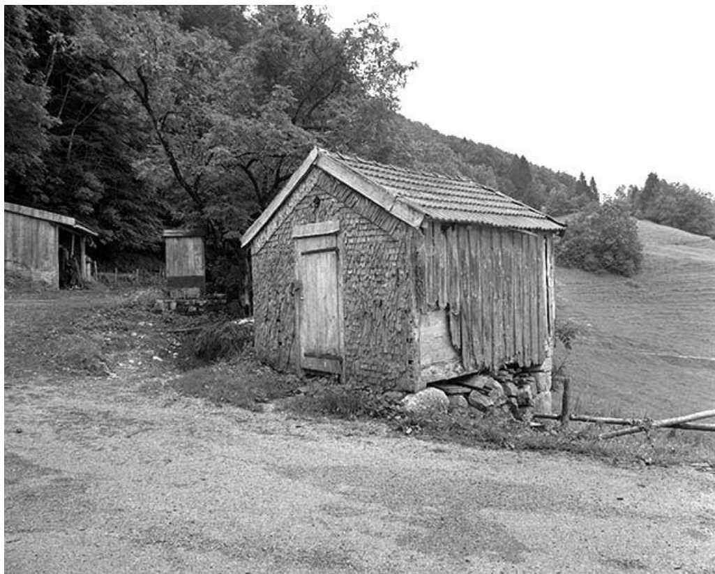
Vue de trois quarts droit du " grenier fort ".
