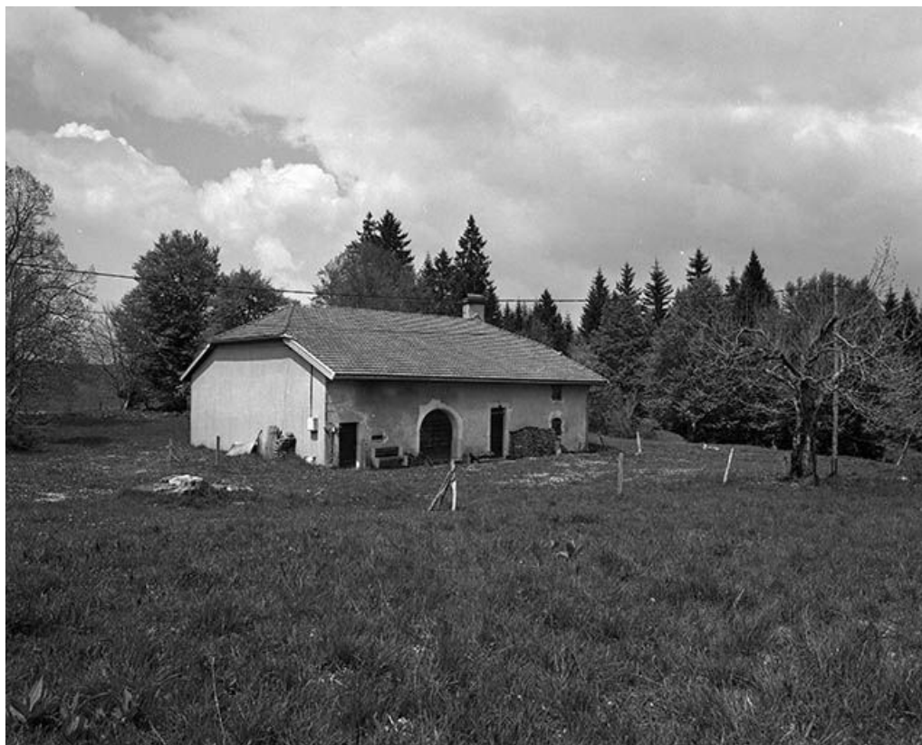
Vue éloignée de la façade antérieure de trois quarts gauche.
