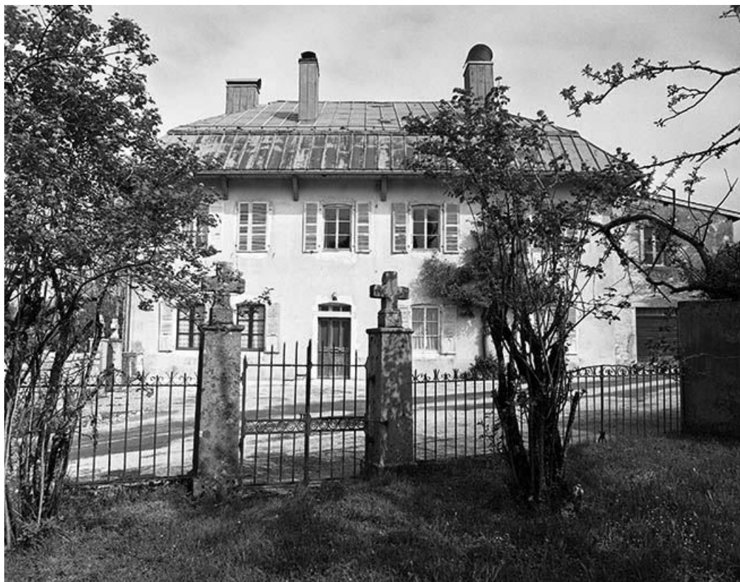
Façade antérieure vue depuis le jardin.
