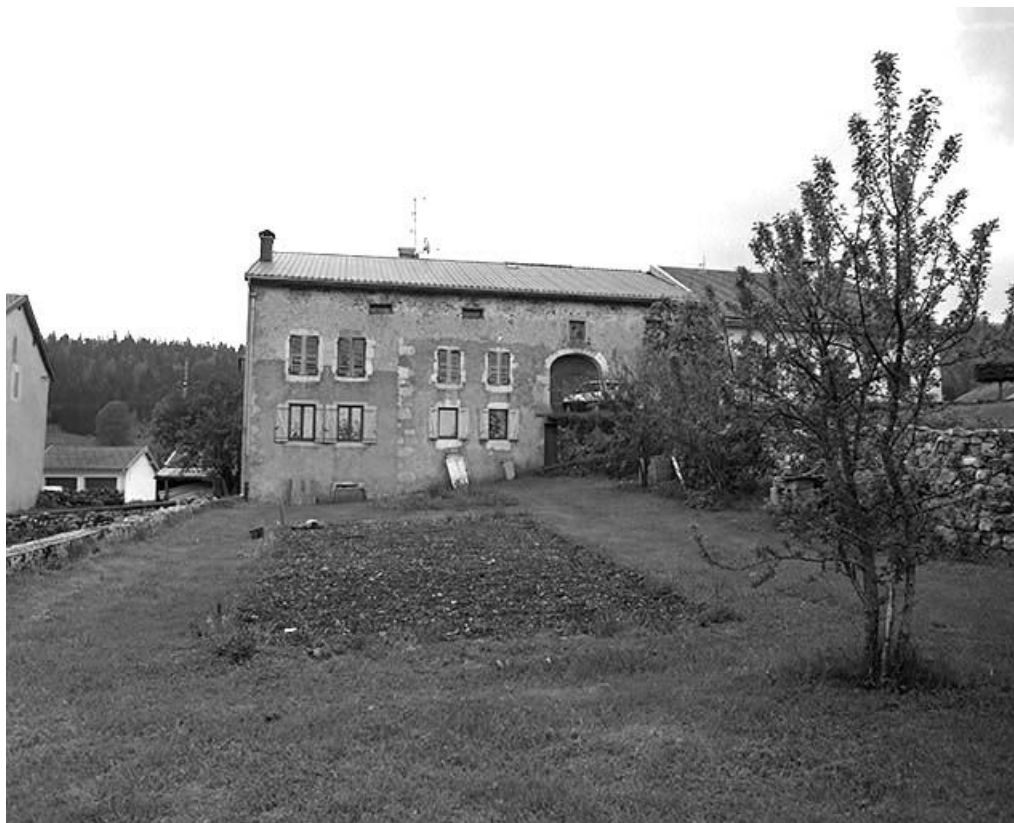
Façade antérieure, vue éloignée.
