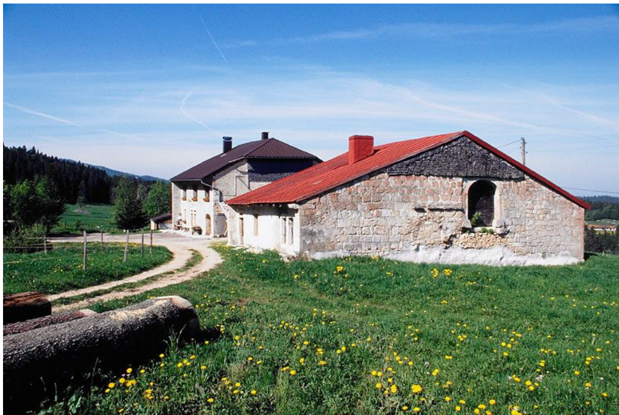
Façade antérieure et face droite vues de trois quarts.
