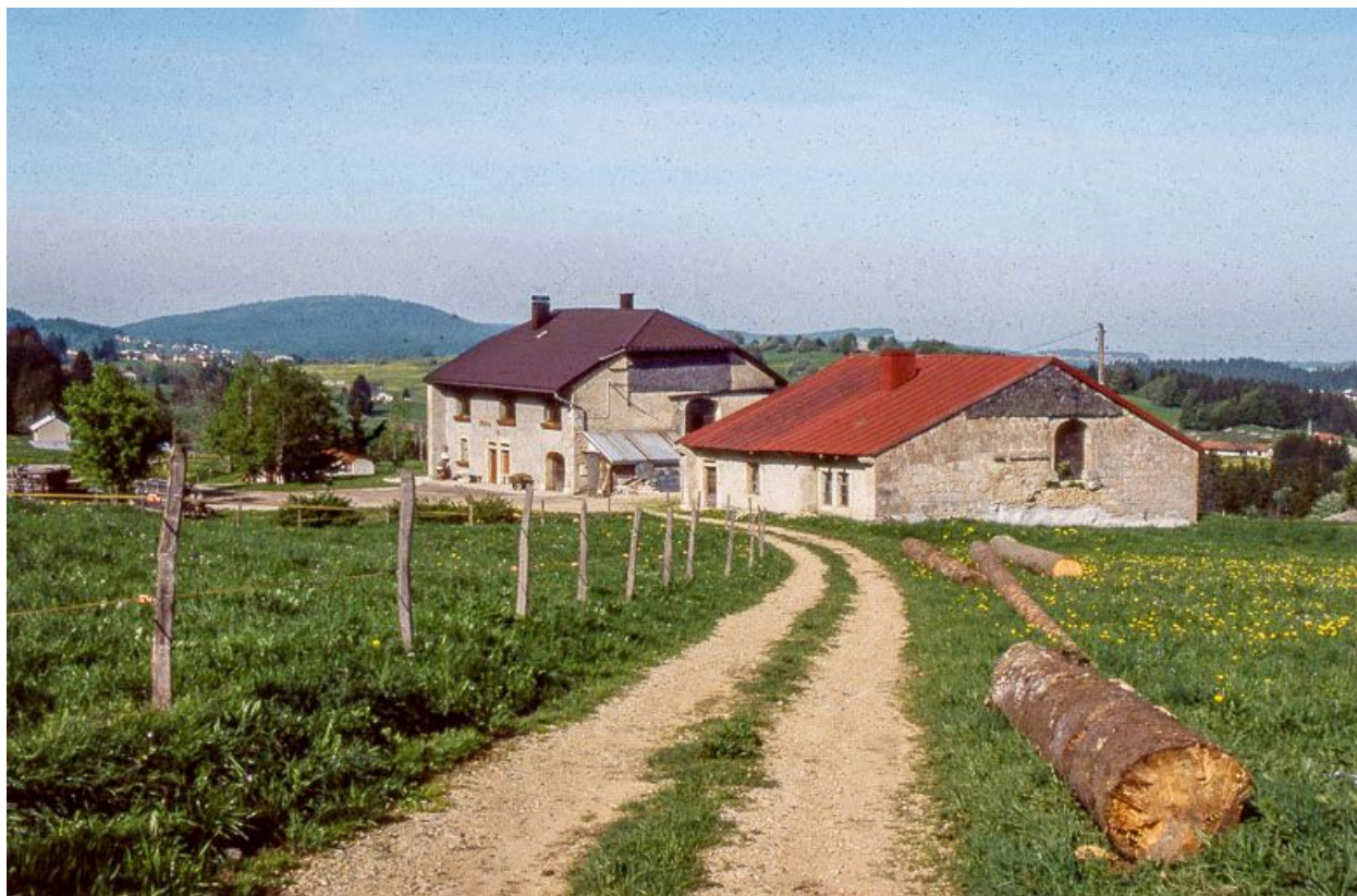
Vue éloignée du bâtiment, façades antérieure et droite.
