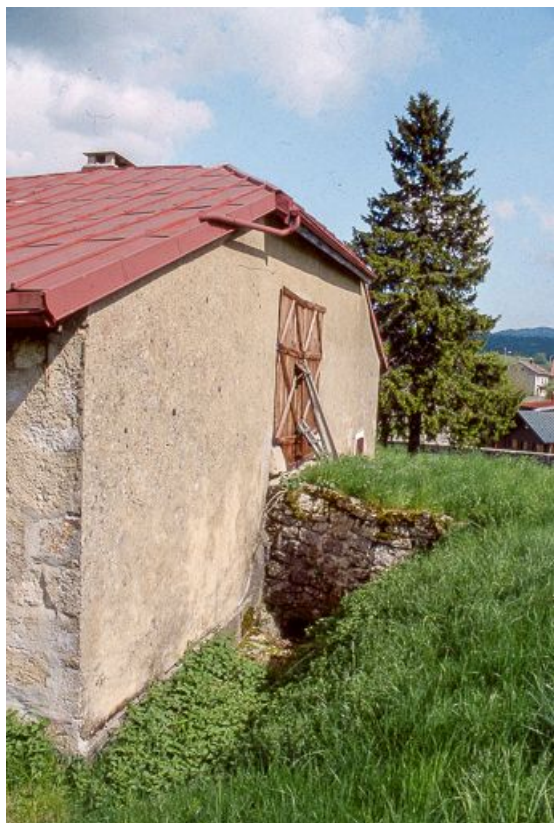
Face gauche et levée de grange.
