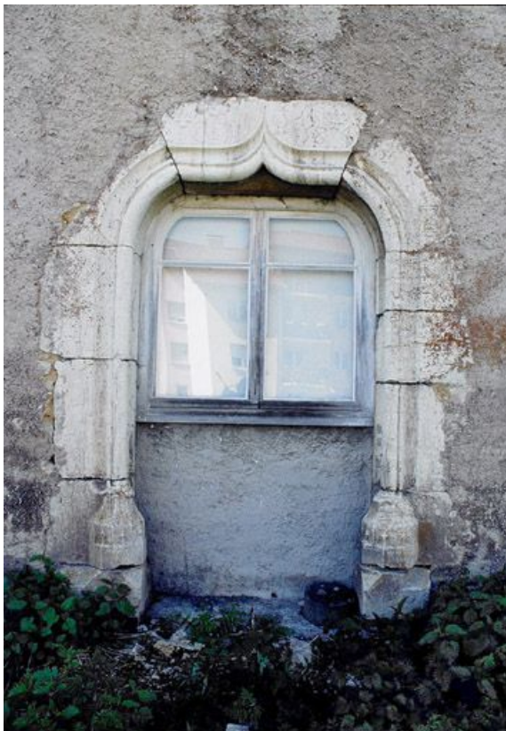
Ouverture avec accolade et moulurations sur la façade postérieure.
