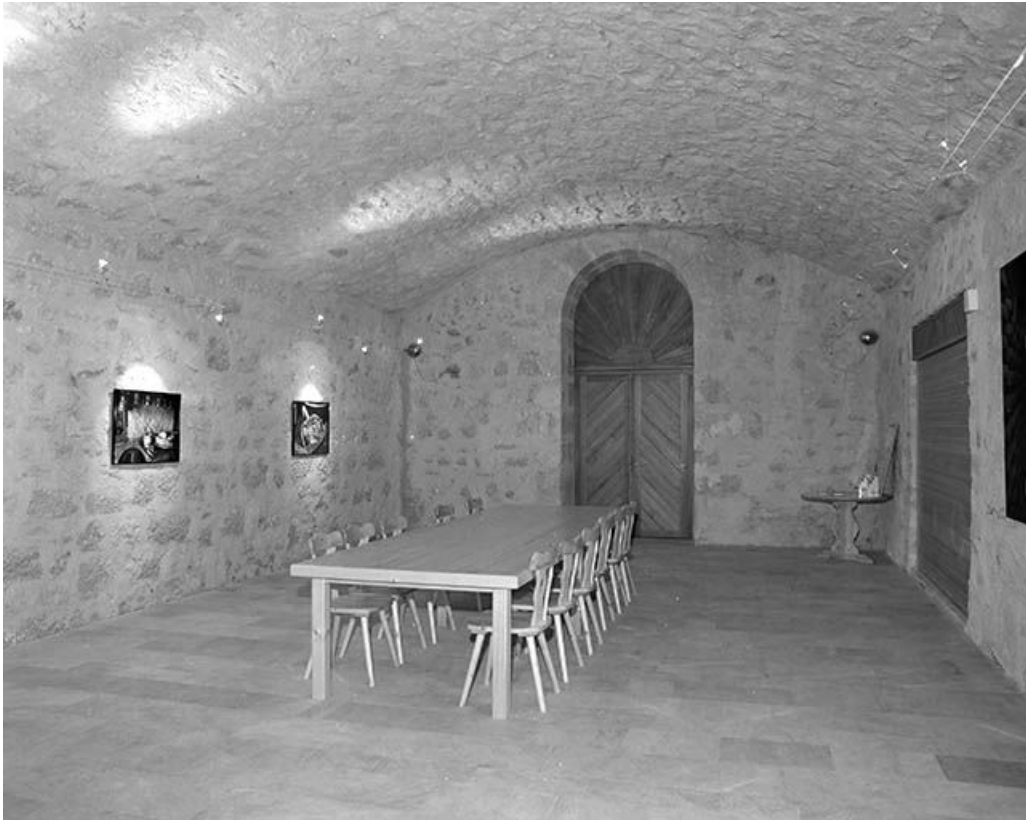
Bâtiment Quitry, salle couverte d'une voûte en berceau segmentaire.
