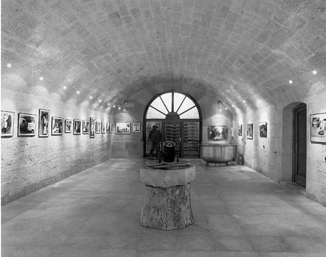
Bâtiment Cavalier, salle couverte d'une voûte en berceau segmentaire.
