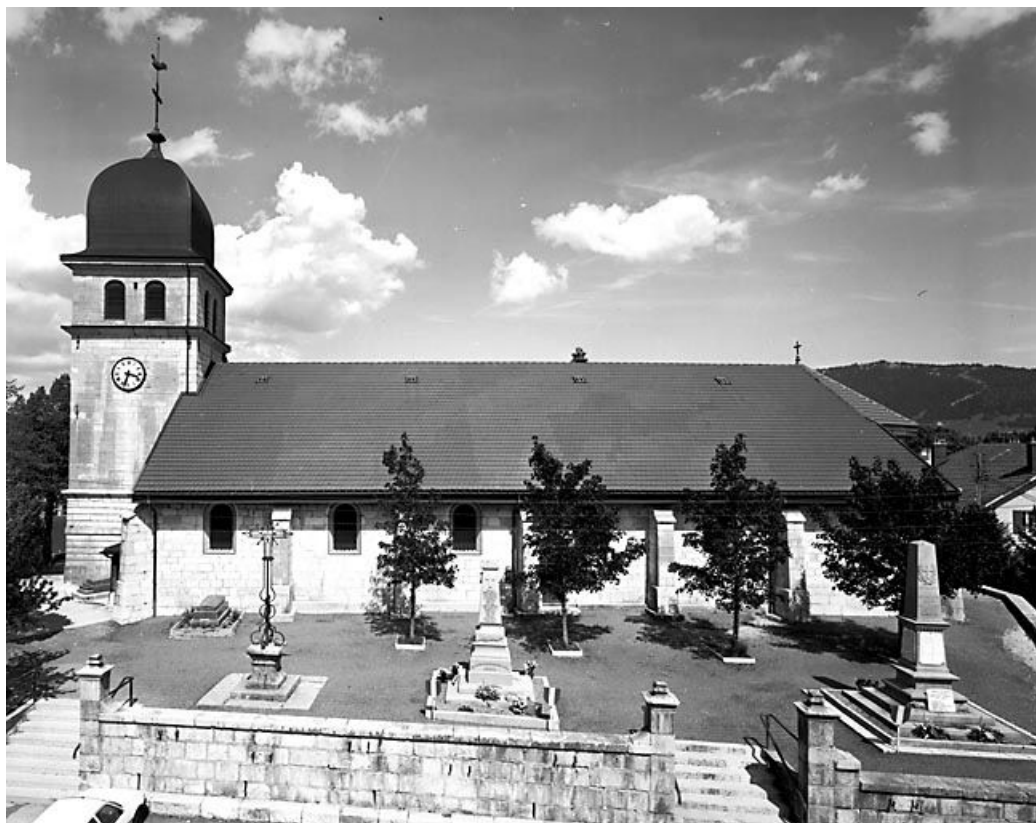
Façade latérale droite.
