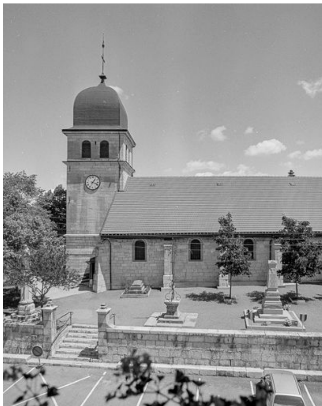
Façade latérale droite.
