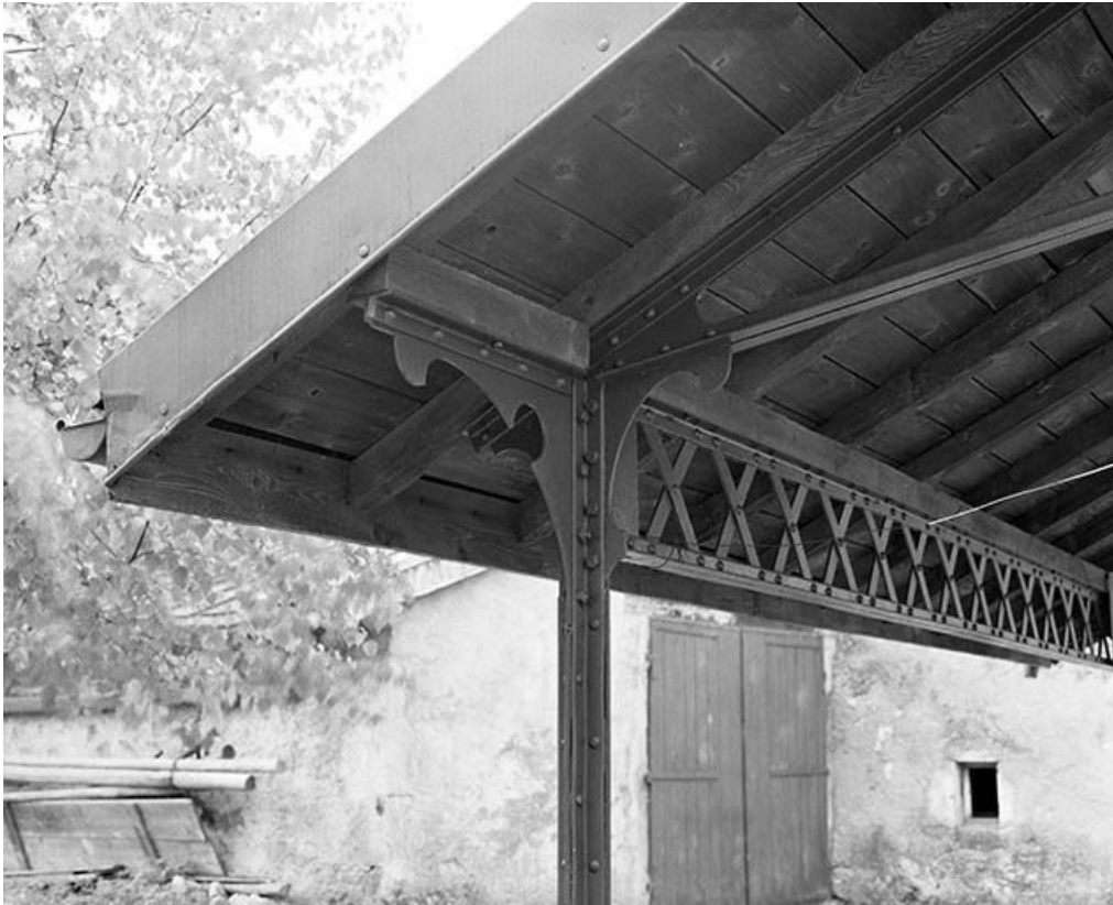
Raccord de la panne sablière et d'un potelet métallique.
