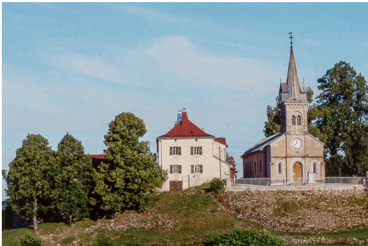
Vue éloignée du presbytère et de l'église.
