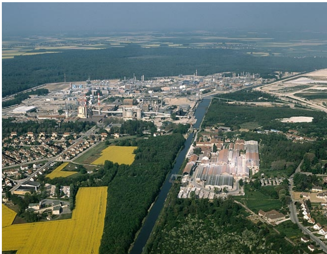
Vue d'ensemble depuis l'est, photographie aérienne.
