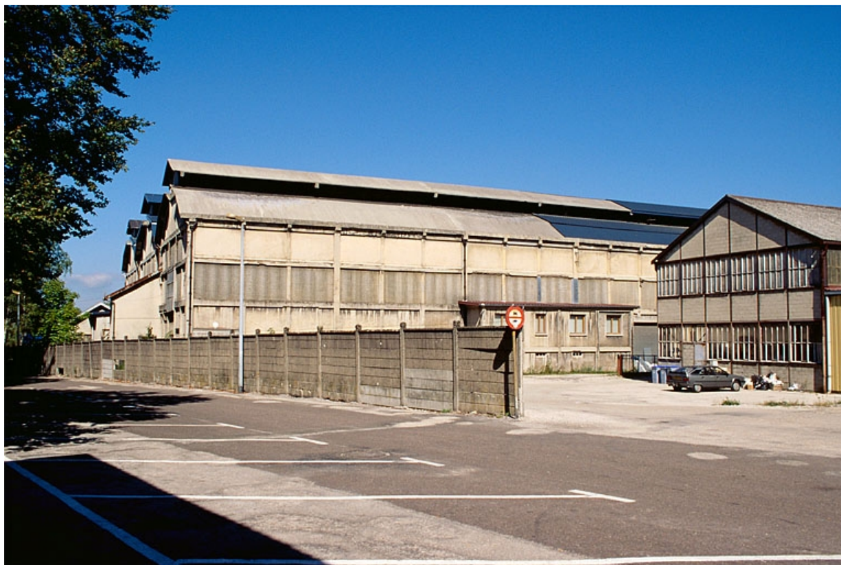
L'ancienne fonderie depuis le sud.
