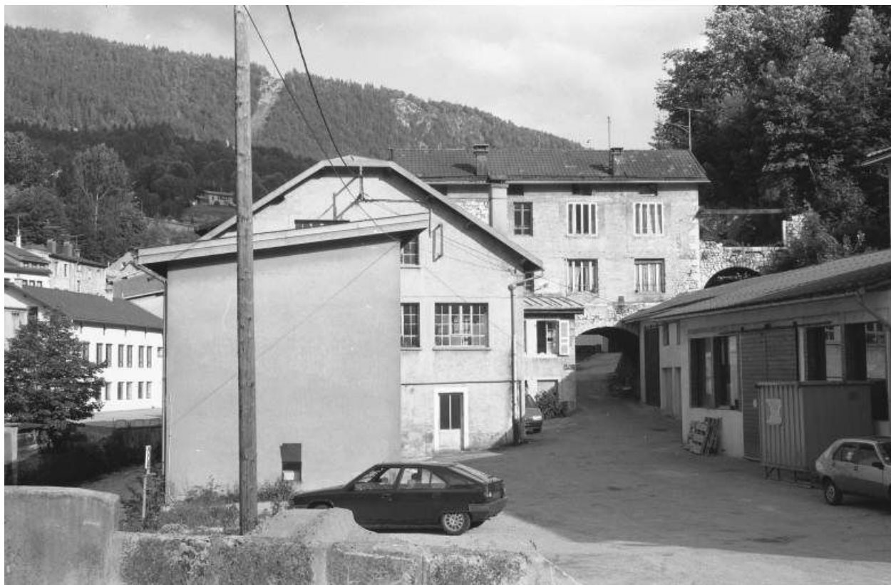
Vue d'ensemble depuis le nord-ouest (aval).
