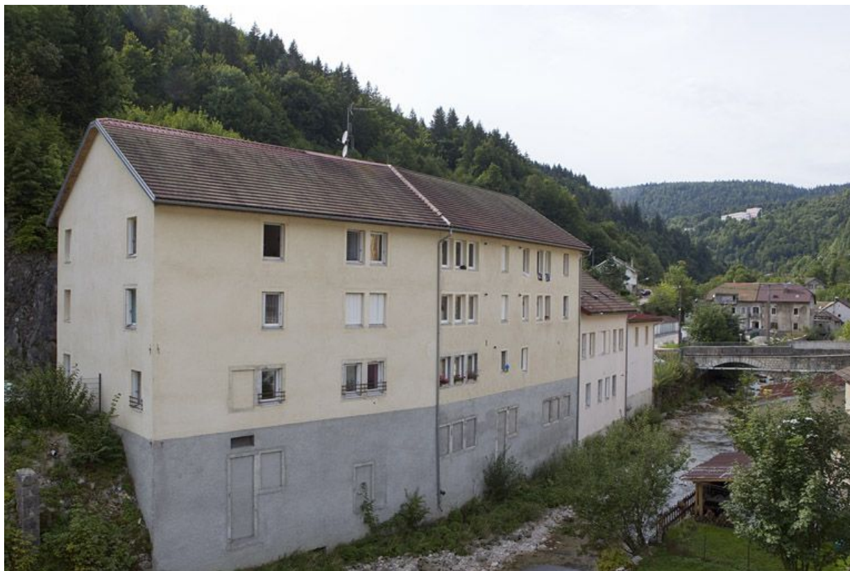
Anciens moulin à blé, usine de quincaillerie (clouterie) et scierie Emmanuel Girod (2 et 4 rue Pierre Morel). 39, Morez, 2 et 4 rue Pierre Morel
