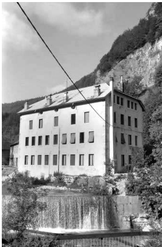
Vue d'ensemble depuis la rive droite de la Bienne, au nord. 39, Morez, 18 rue Pierre Morel
