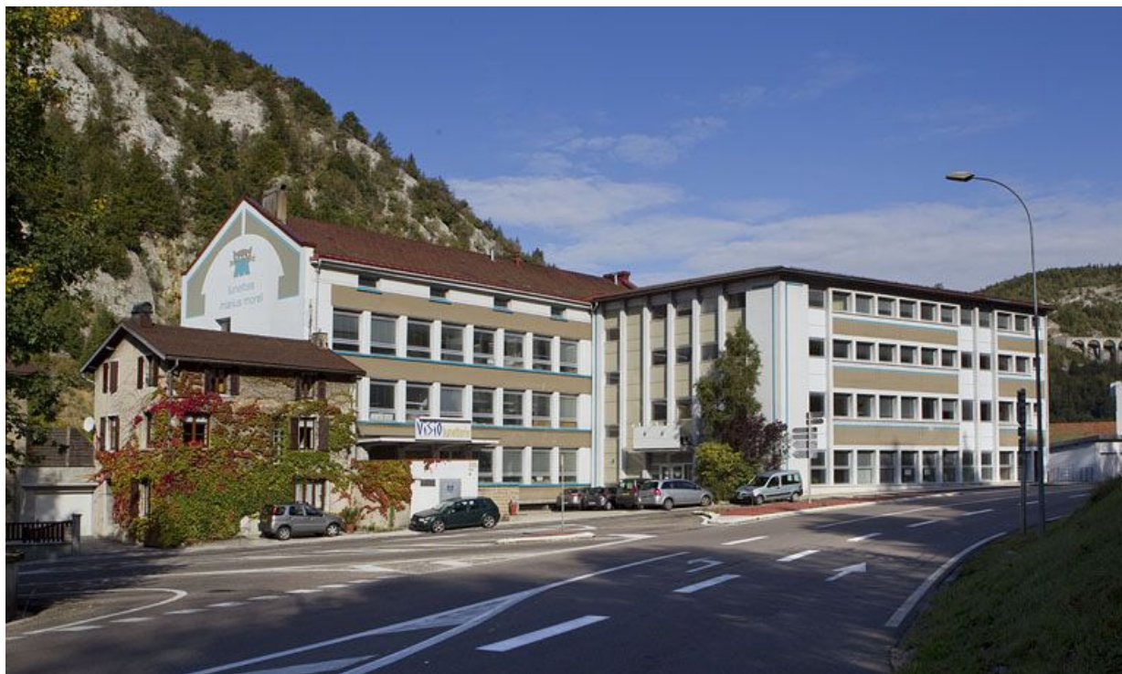
Ancienne usine de lunetterie Marius Morel (18 à 22 avenue Charles de Gaulle), actuellement Visio Lunetterie. 39, Morez
