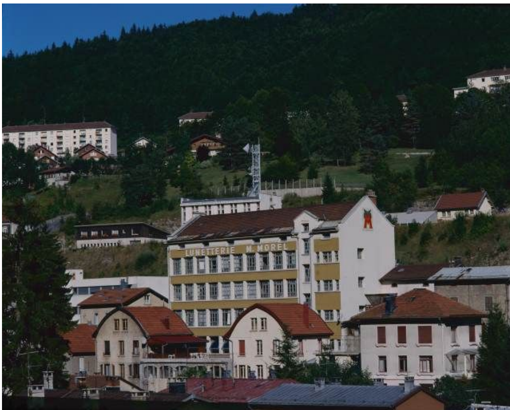
Façade postérieure du bâtiment de 1936, de trois quarts droite.
