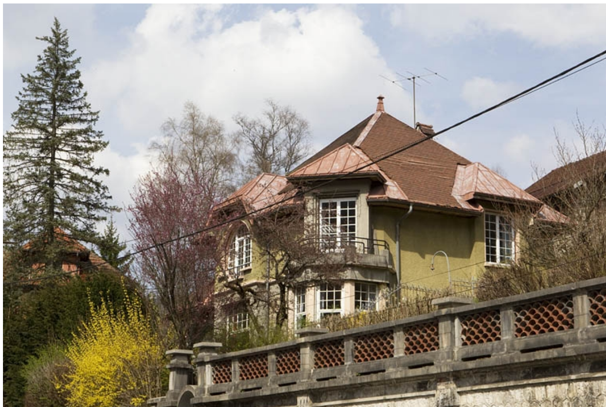
Logement patronal : vue d'ensemble, depuis le sud.
