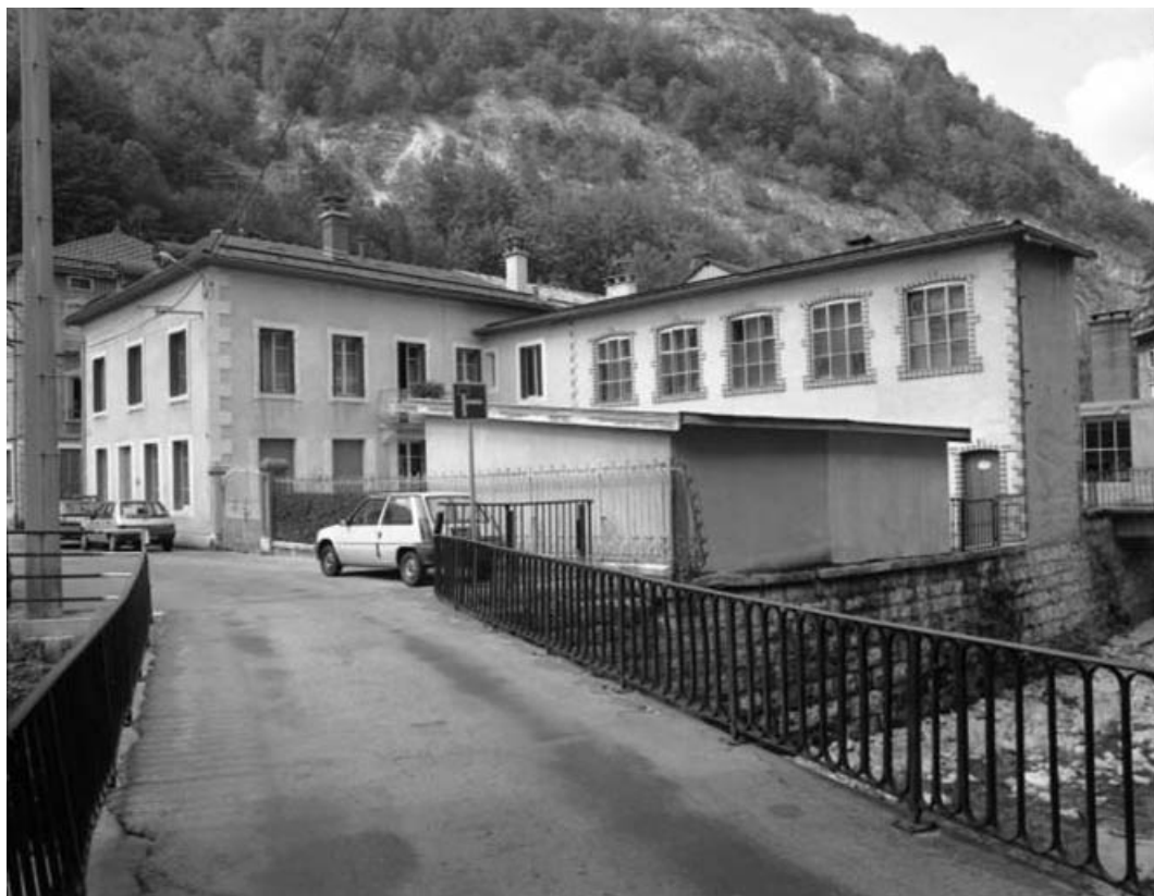
Vue d'ensemble du logement patronal, depuis le pont de la rue du Casino. 39, Morez, 11 rue de l' Industrie
