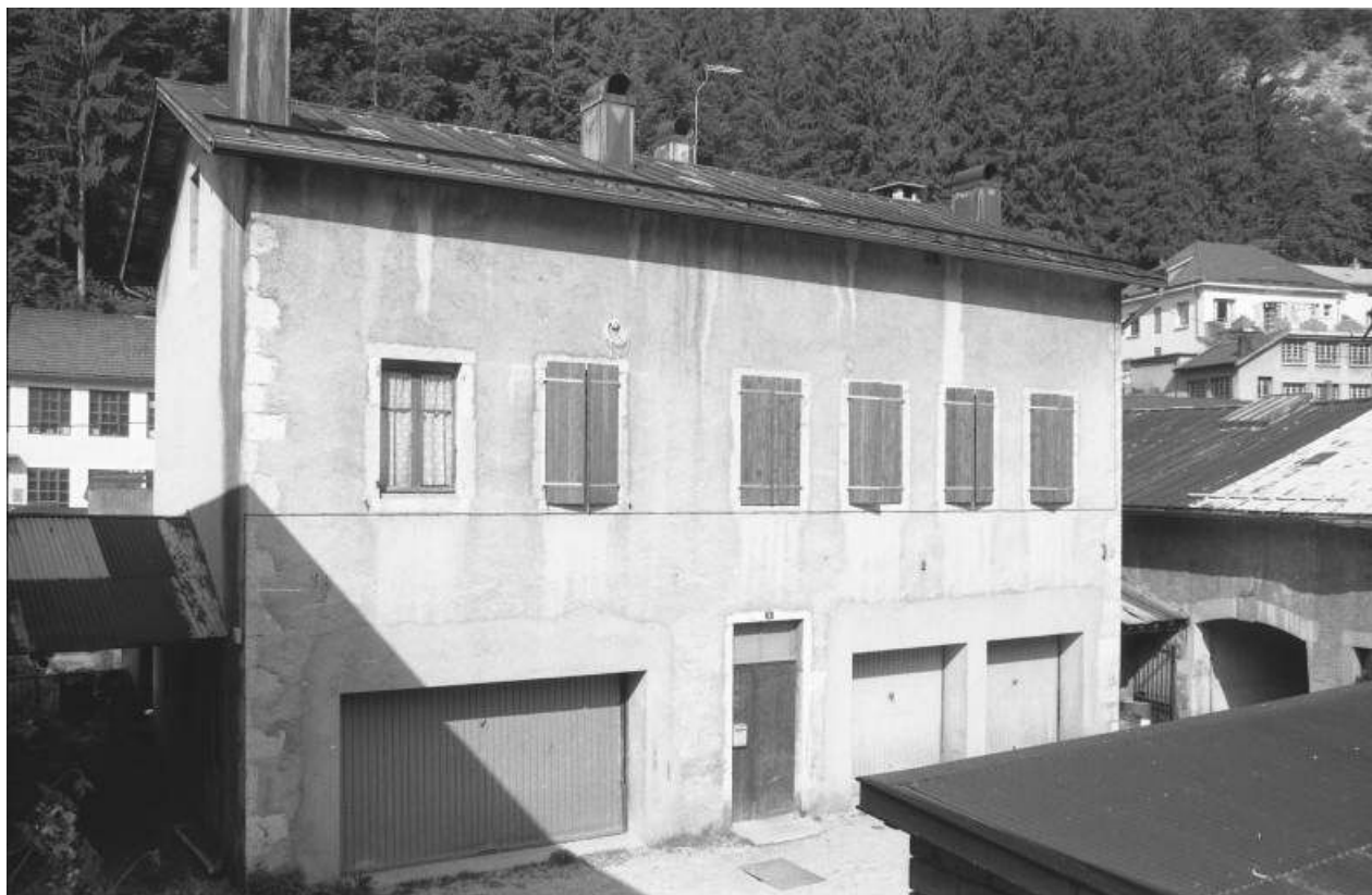
Façade de l'ancienne fonderie, sur la 2e cour.
