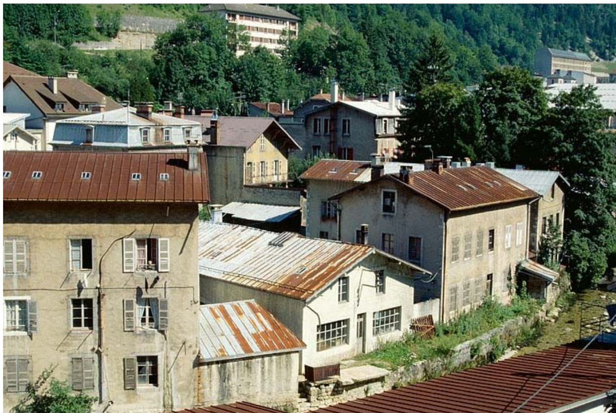
Façade latérale droite de l'atelier de fabrication et ancienne fonderie, sur la Bienne. 39, Morez, 1 à 13 cour Paul Odobey
