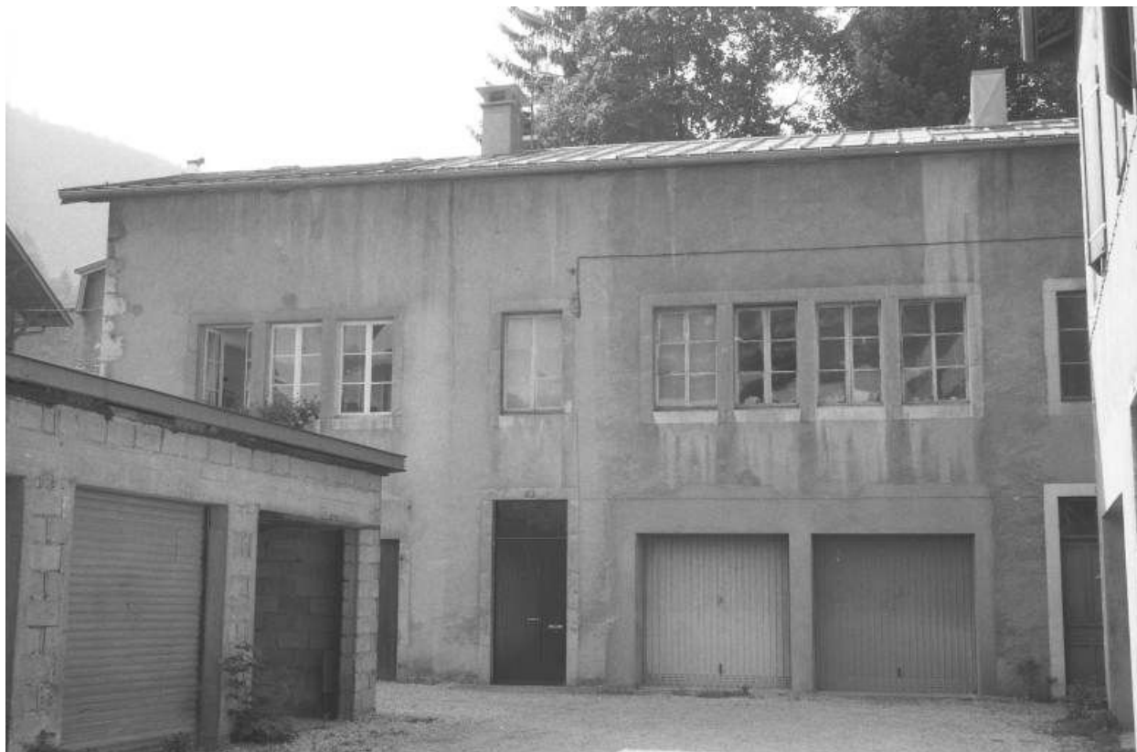
Autre bâtiment de l'ancienne fonderie, dans la 2e cour.
