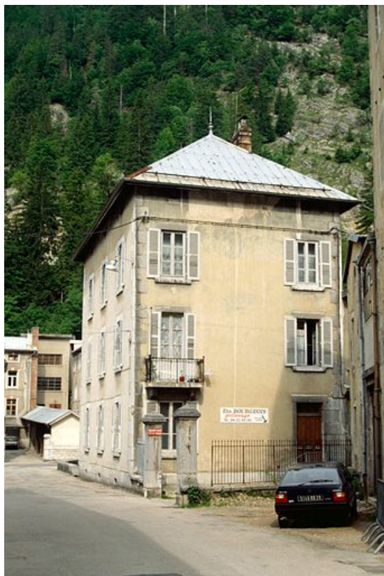
2e bâtiment rue Victor Poupin : façades antérieure et latérale gauche. 39, Morez, 199 rue de la République
