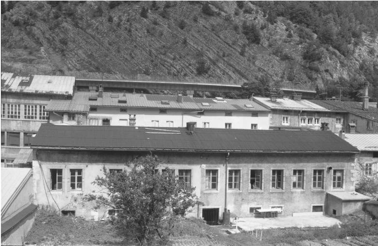
Façade postérieure des ateliers en fond de cour, aux n° 196 et 198.
