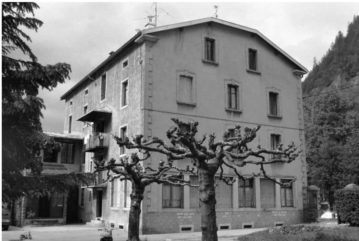
Façades postérieure et latérale gauche du logement patronal.
