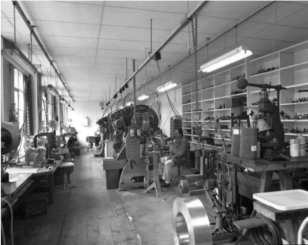
Intérieur de l'atelier au rez-de-chaussée.
