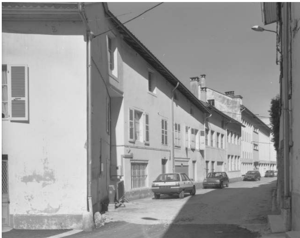
Façade antérieure des ateliers de fabrication, de trois quarts gauche.
