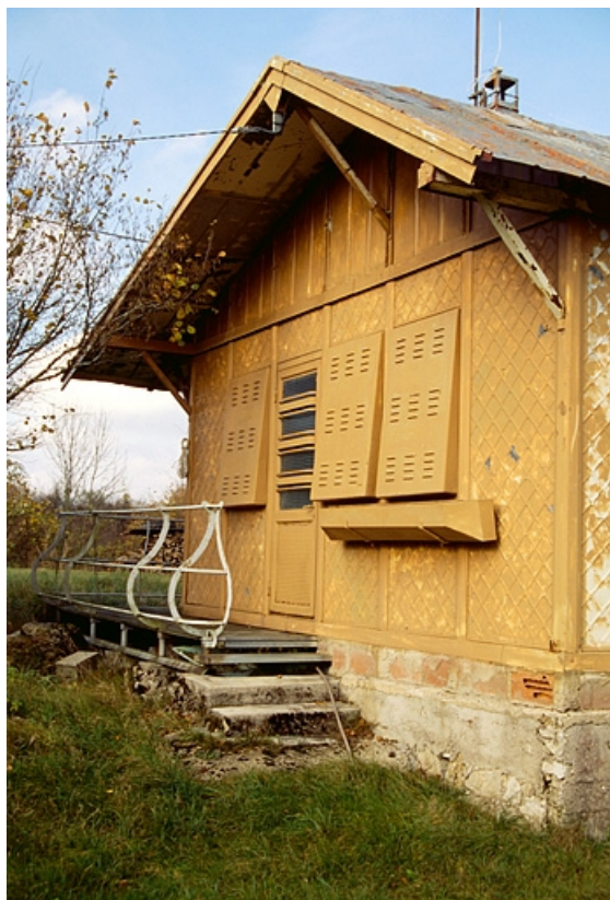
Façade latérale droite, vue de trois quarts droite.
