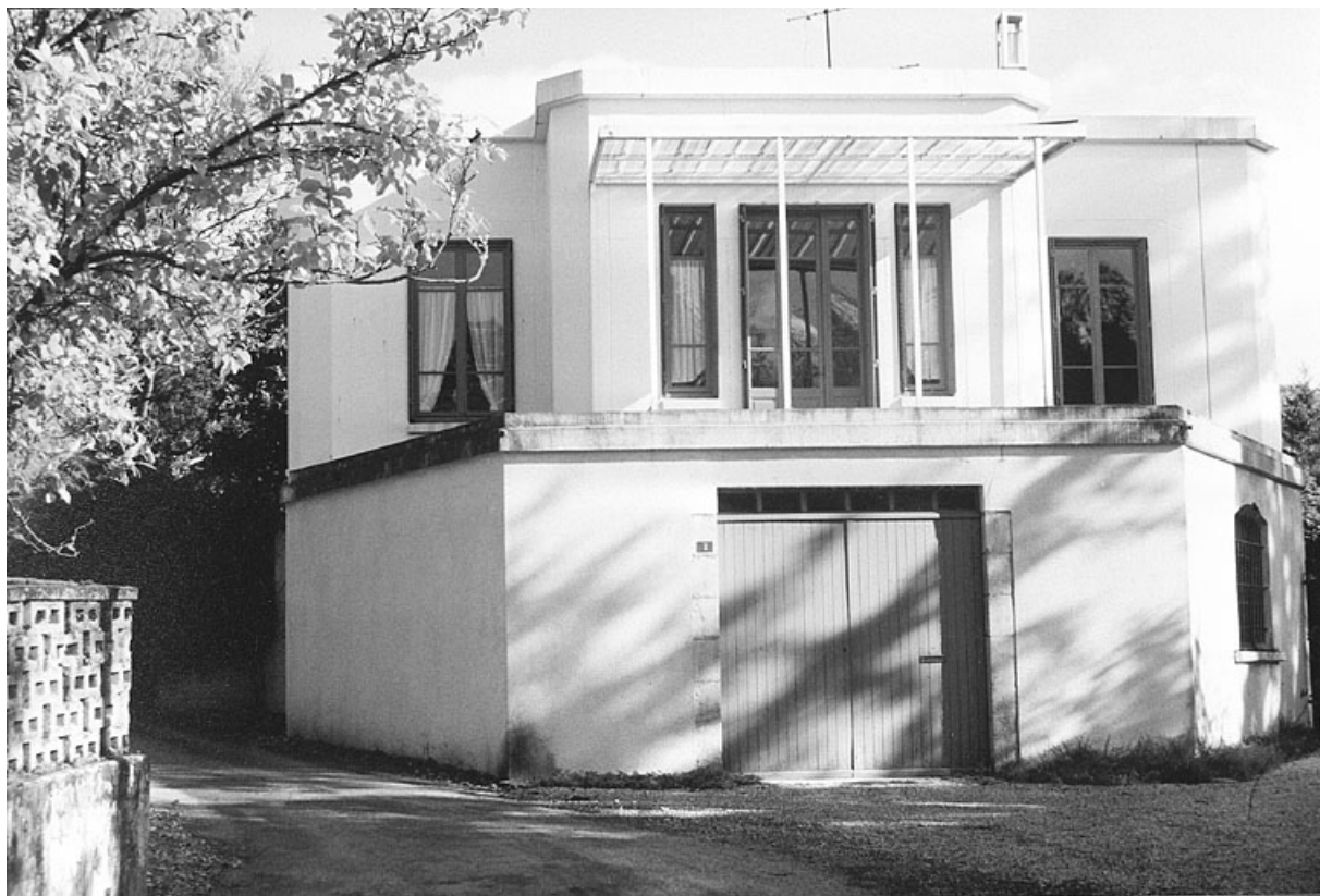
Façade antérieure avant restauration.
