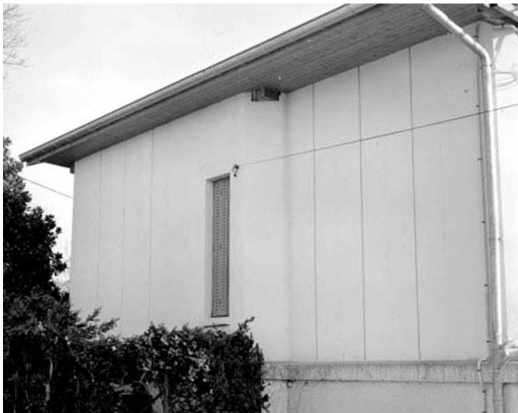
Façade latérale gauche : détail du mur.
