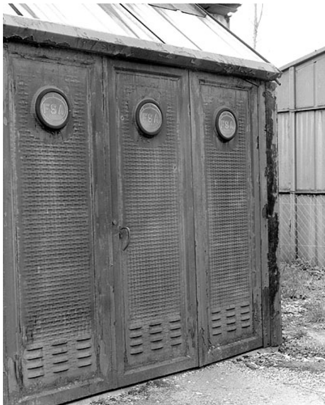
Remise d'automobile métallique : porte d'entrée.
