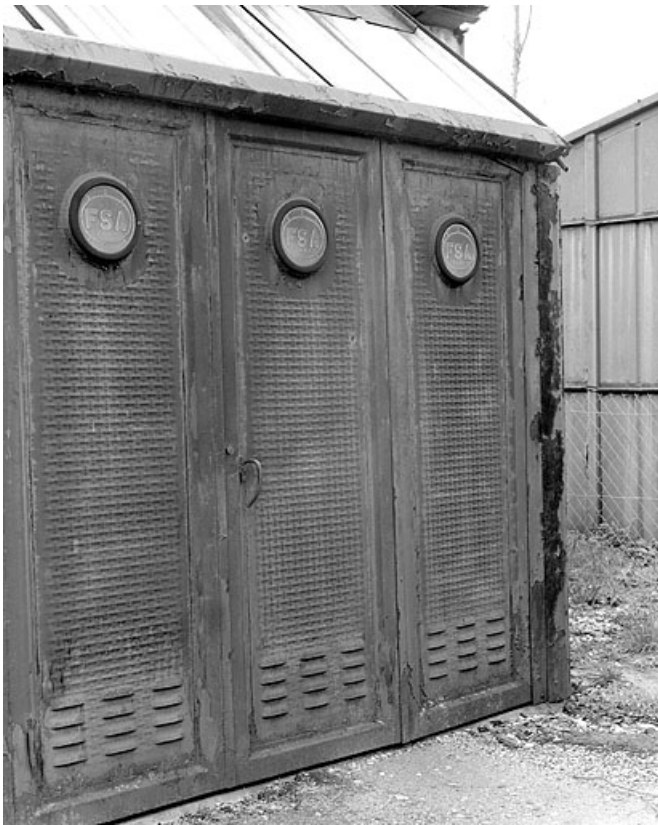
Remise d'automobile métallique : porte d'entrée.
