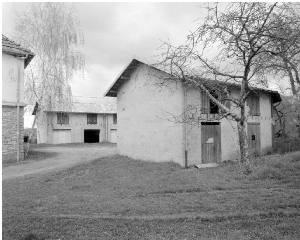
Remise d'automobile et bûcher (F) : vue d'ensemble.
