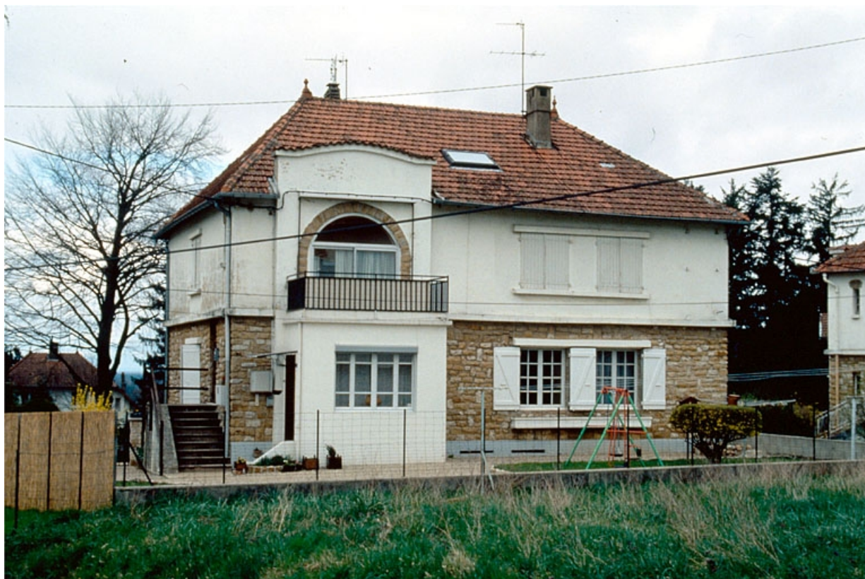
Maison (H) : façade postérieure.
