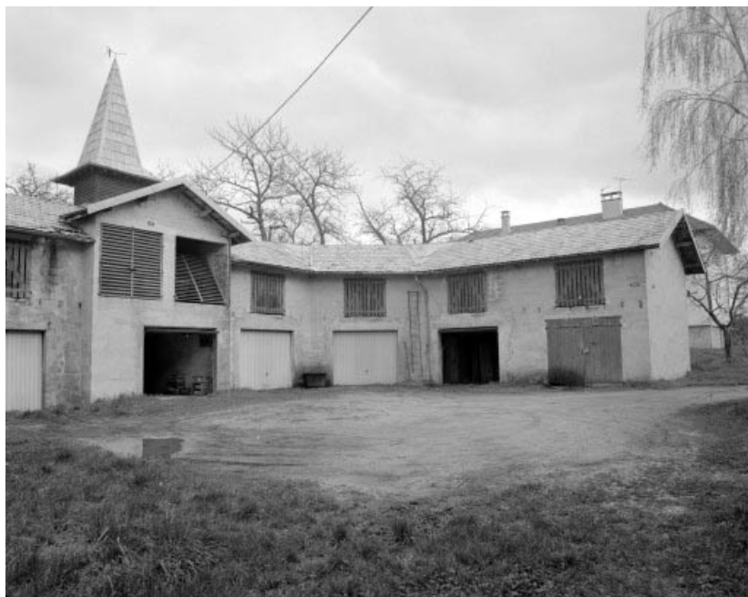
Remise d'automobile et bûcher (F) : cour.
