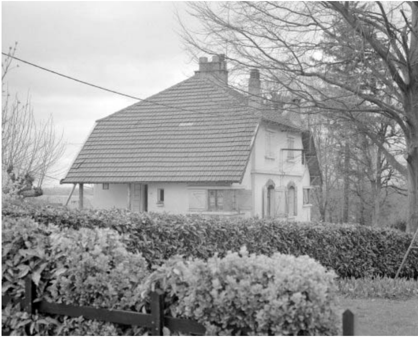
Maison (B) : façades postérieure et latérale droite.
