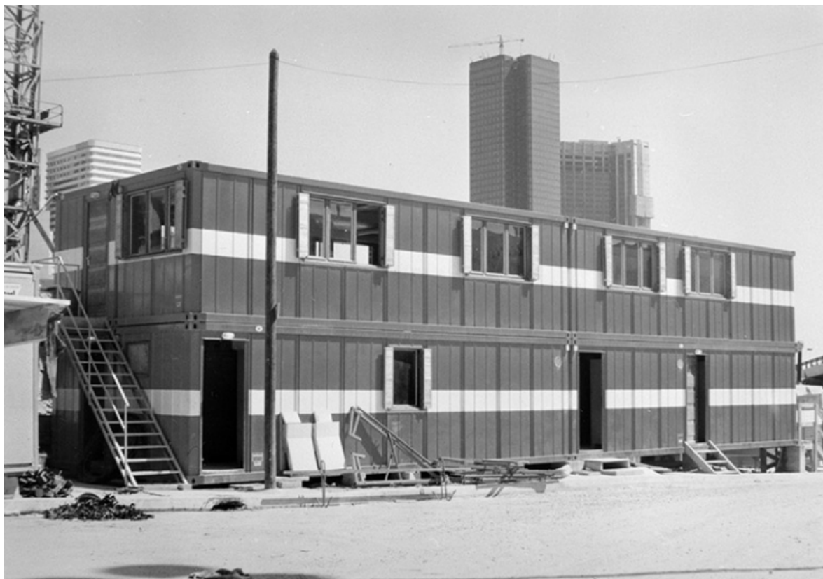
Logiblocs, Paris [cellules monoblocs, sur le chantier de construction du C.N.I.T. ?]. 39, Saint-Amour, 5, 7 rue Philibert de la Baume
