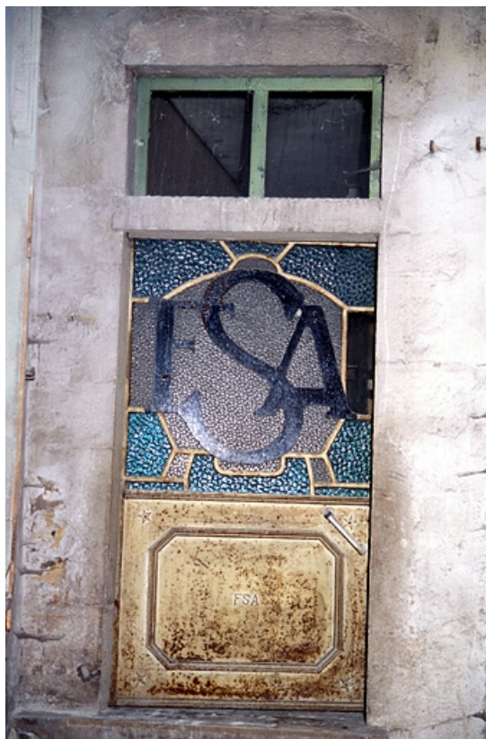
Cour couverte et atelier des presses (B) : porte d'accès à l'ancien hôtel de voyageurs (A). 39, Saint-Amour, 25 rue Lamartine
