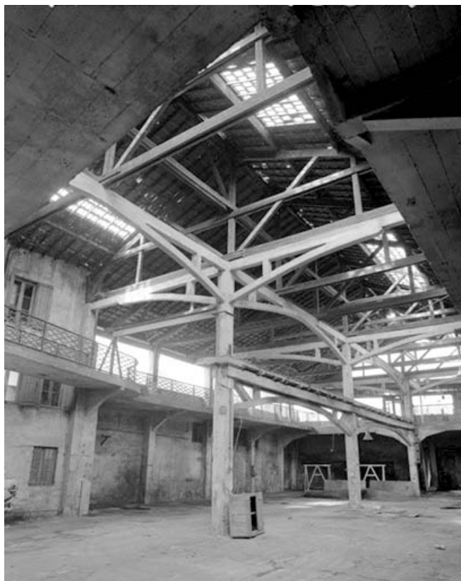
Cour couverte et atelier des presses (B) : poteaux en béton armé. 39, Saint-Amour, 25 rue Lamartine
