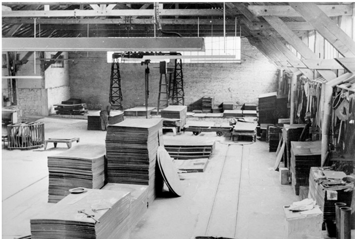
Intérieur de l'entrepôt industriel (J2) avec traçage et découpage. 39, Saint-Amour, 25 rue Lamartine
