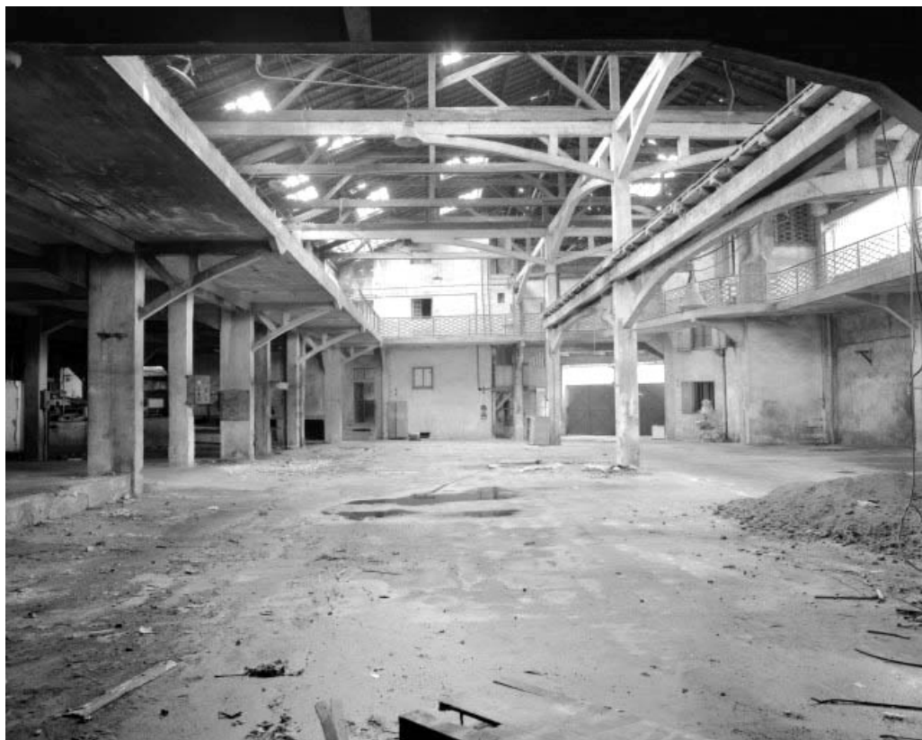
Cour couverte et atelier des presses (B) : vue du fond.
