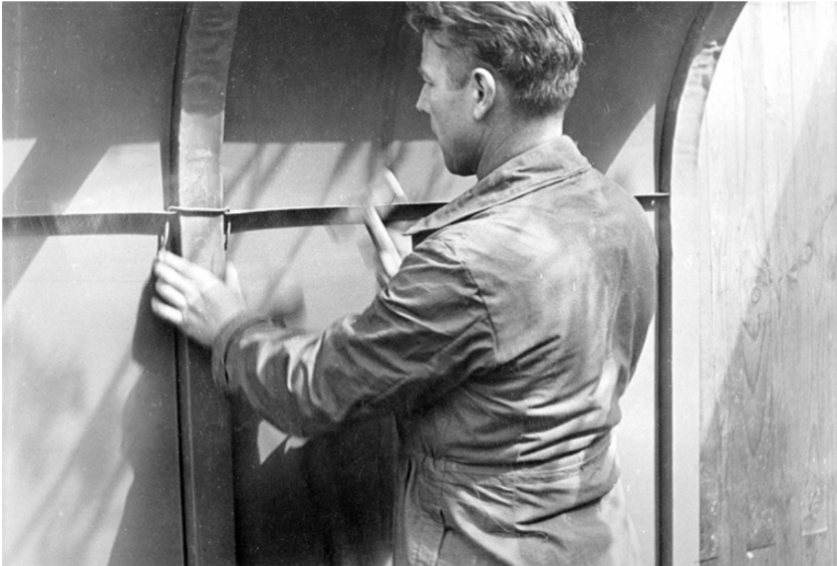
Montage d'un baraquement métallique : pose d'une agrafe.
