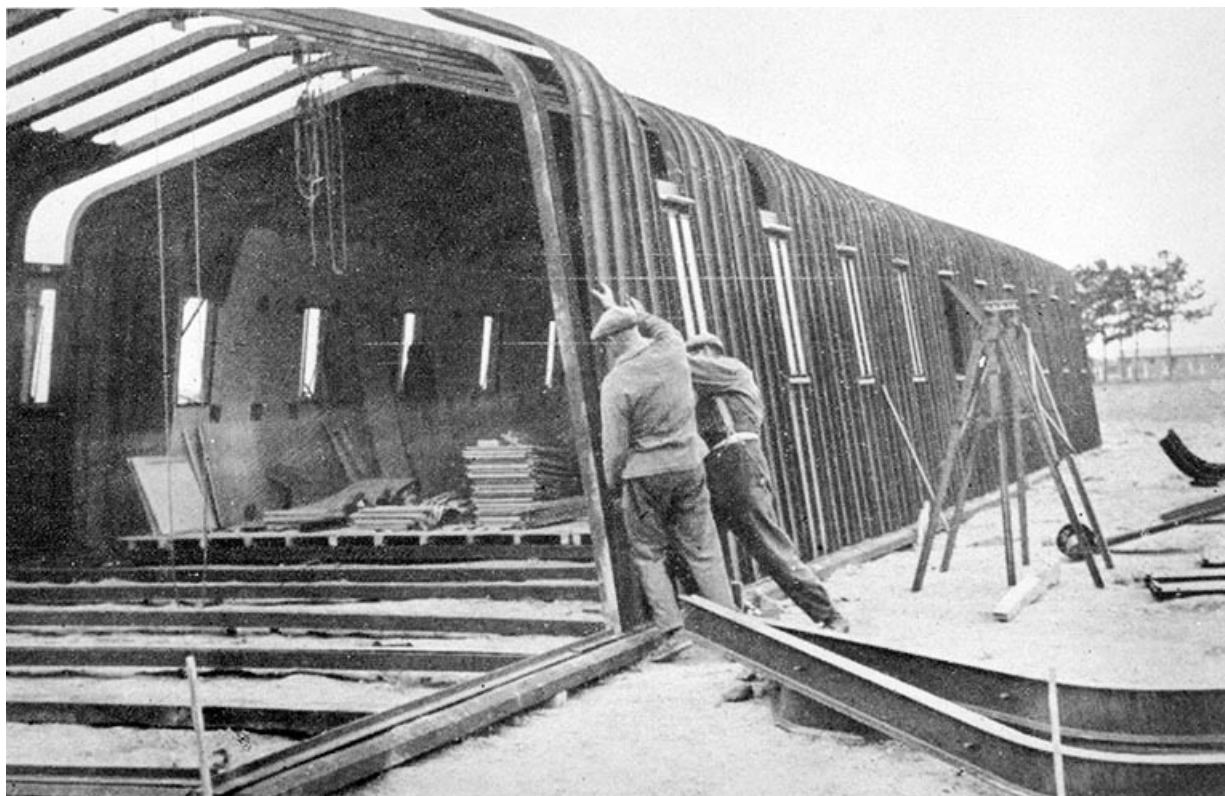
Montage d'un baraquement métallique dans les années 1940 : mise en place d'une tôle du mur. 39, Saint-Amour, 25 rue Lamartine
