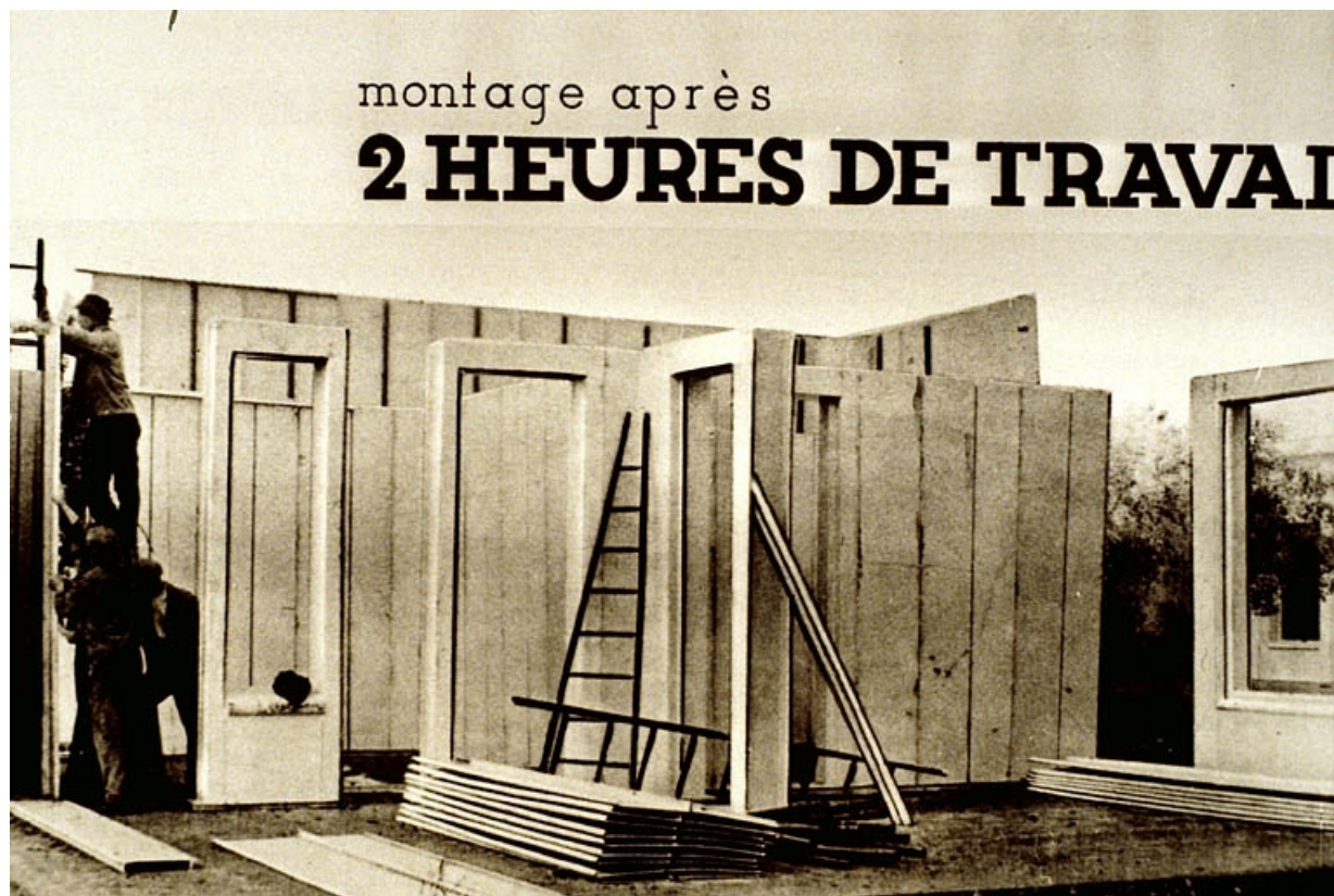
Montage d'une maison tout acier dans les années 1930 : mise en place des murs.
