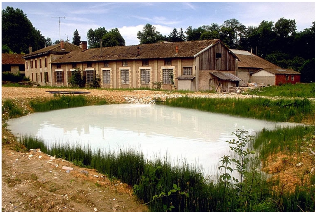
Logement patronal (H), atelier des marbriers et bassin de décantation.
