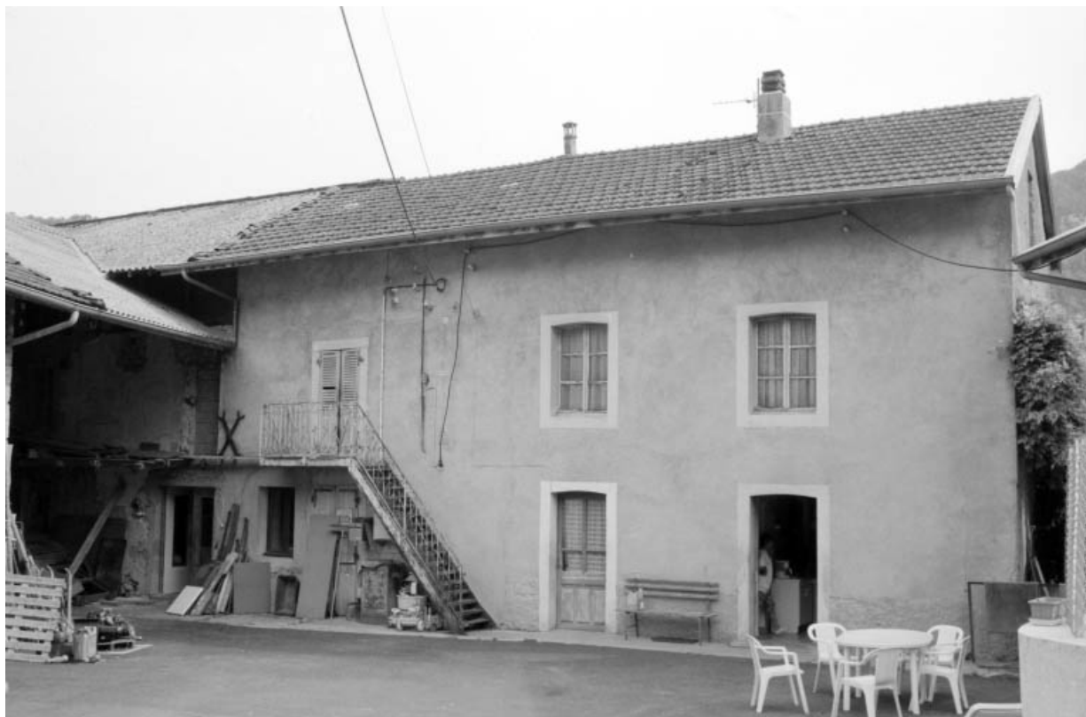
Façade antérieure du logement.
