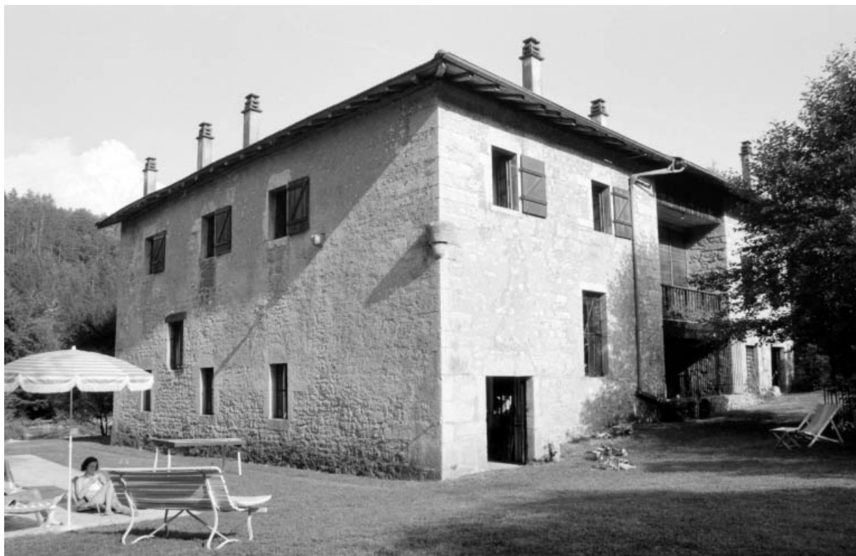
Façade antérieure du moulin, vue de trois quarts gauche. 39, Genod, lieudit : les Planches
