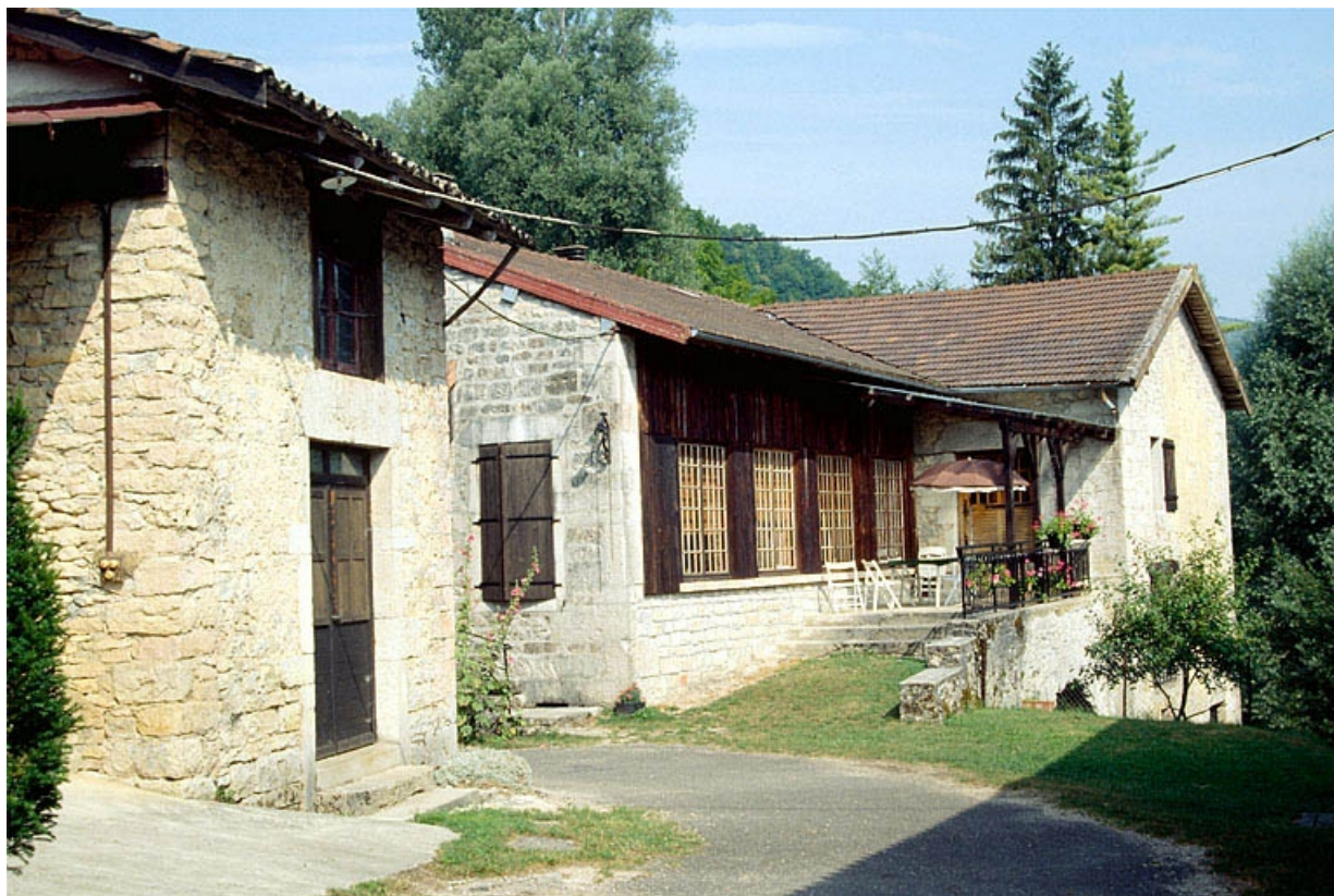
Façade postérieure du moulin et bâtiment (B).
