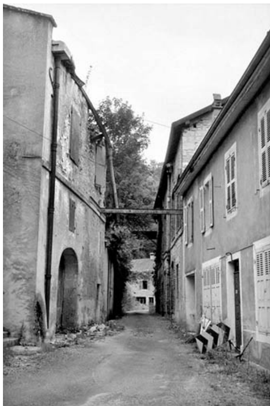
Logement de contremaître, bureau et atelier de fabrication.
