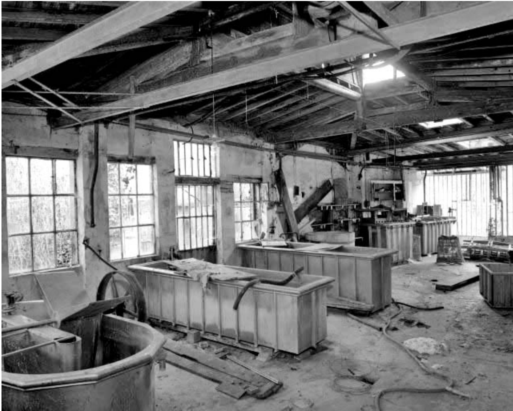
Intérieur de l'atelier de teinture (bâtiment P).
