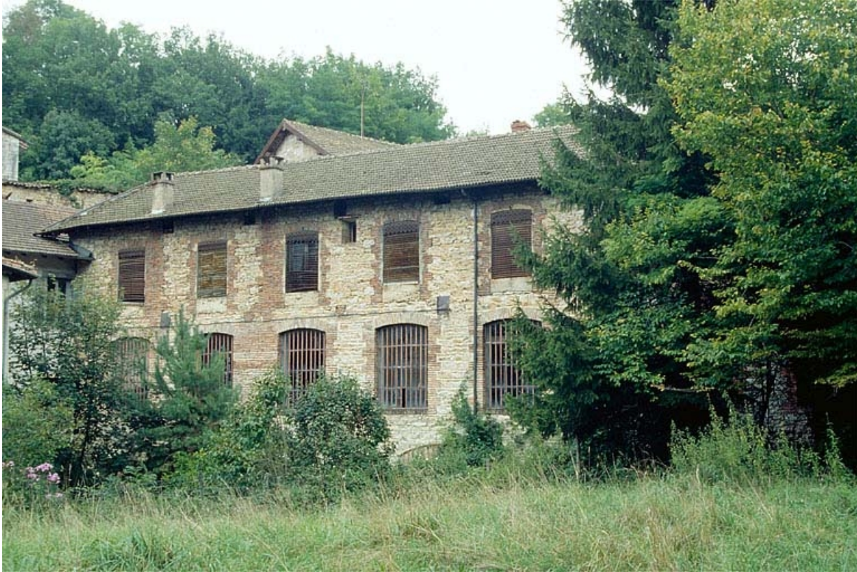
Atelier de fabrication (N) vu du sud.
