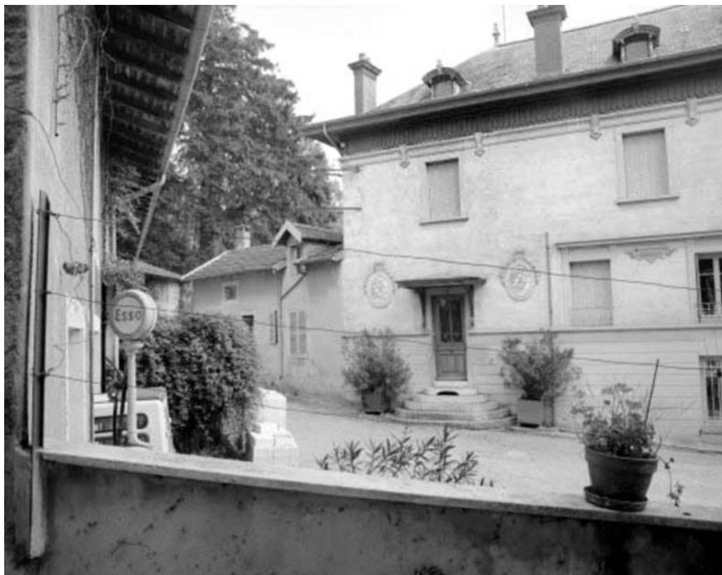
Logement (D) et façade latérale gauche du bureau. 39, Balanod
