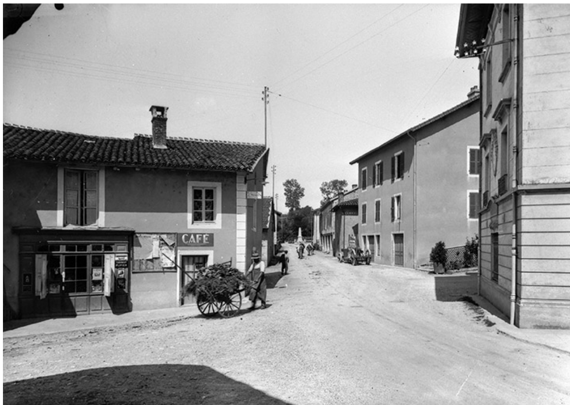
Café, logement patronal et logement d'ouvriers. 39, Balanod
