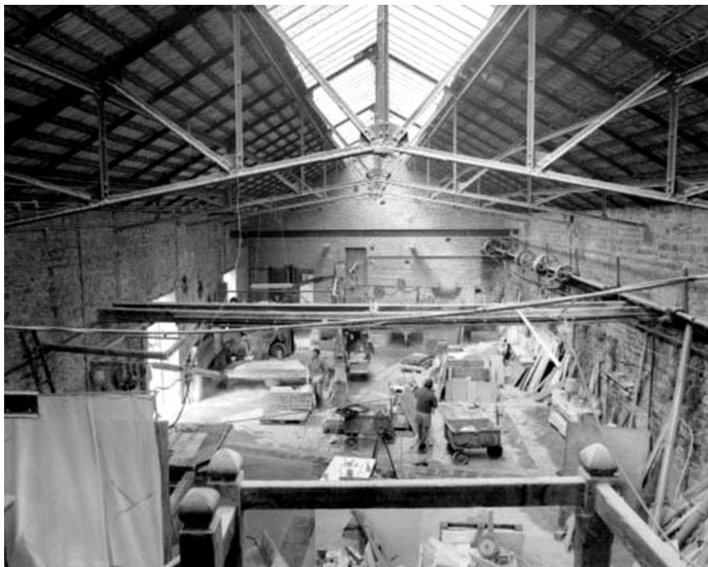
Intérieur de l'atelier central (débitage-polissage). 39, Balanod
