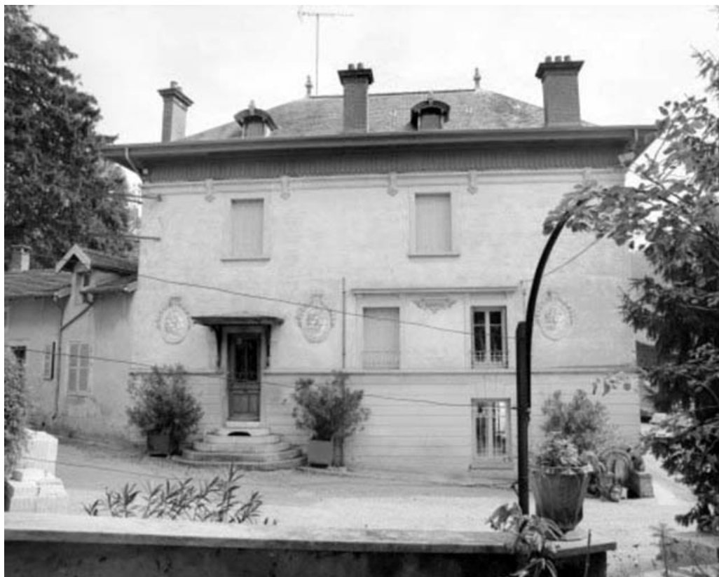
Façade latérale gauche du bureau.
