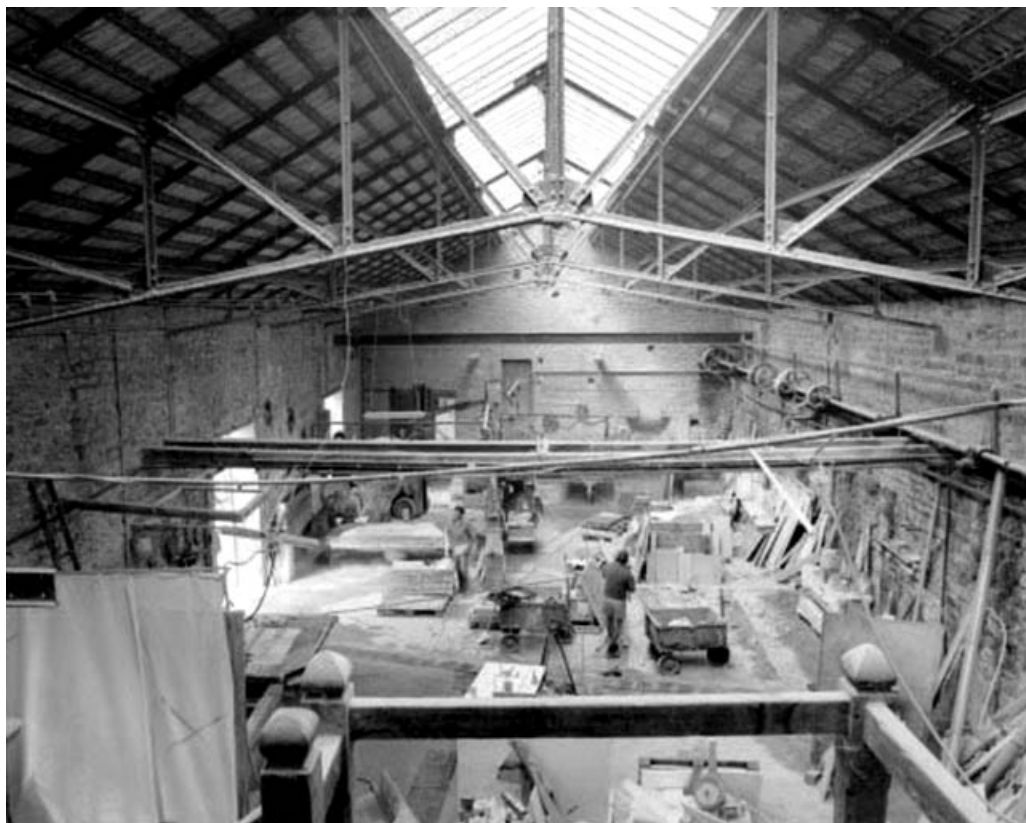
Intérieur de l'atelier central (débitage-polissage). 39, Balanod
