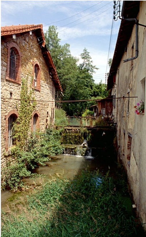
Canal vu d'aval, façade postérieure de l'atelier de réparation et façade latérale de l'atelier de fabrication. 39, Saint-Amour, 4, 6 rue des Sources
