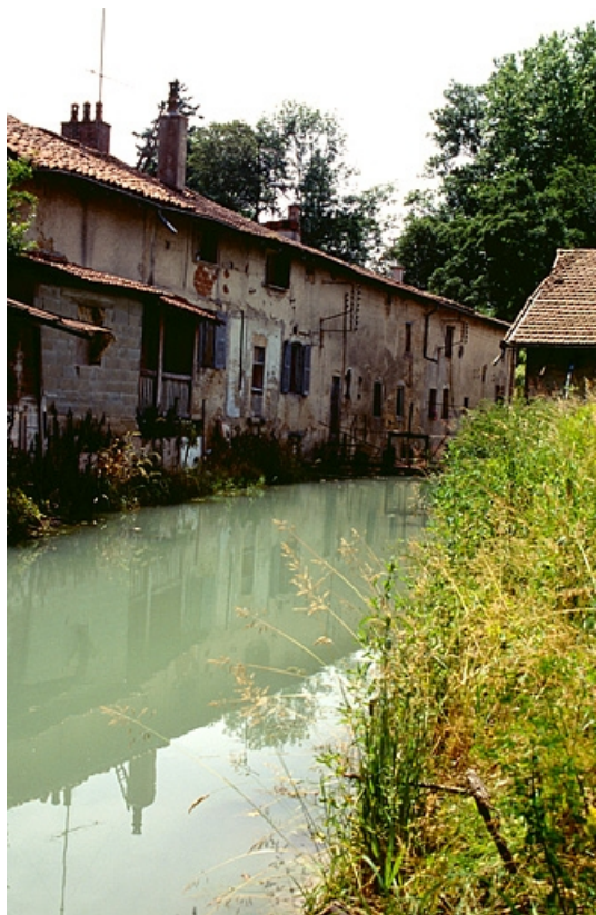
Canal vu d'amont et façade postérieure du logement, de l'atelier de réparation et du bureau. 39, Saint-Amour, 4, 6 rue des Sources
