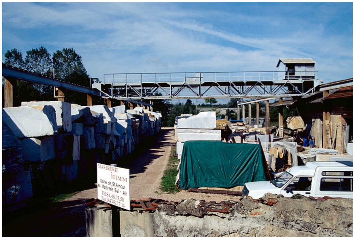
Pont roulant et aire des matières premières, vus depuis l'entrée à l'est.
