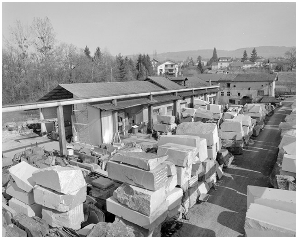
Vue d'ensemble des bâtiments depuis l'ouest.
