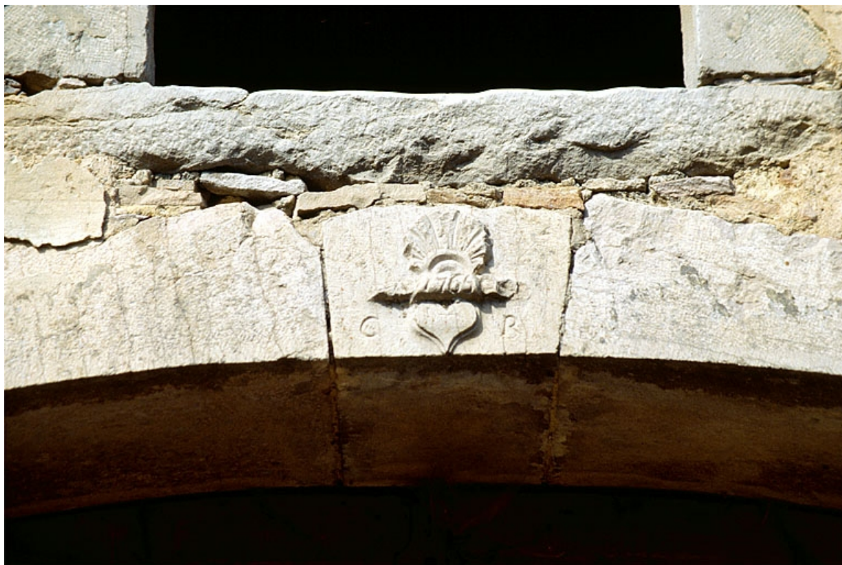
Bâtiment du bureau : clé de voûte sculptée.
