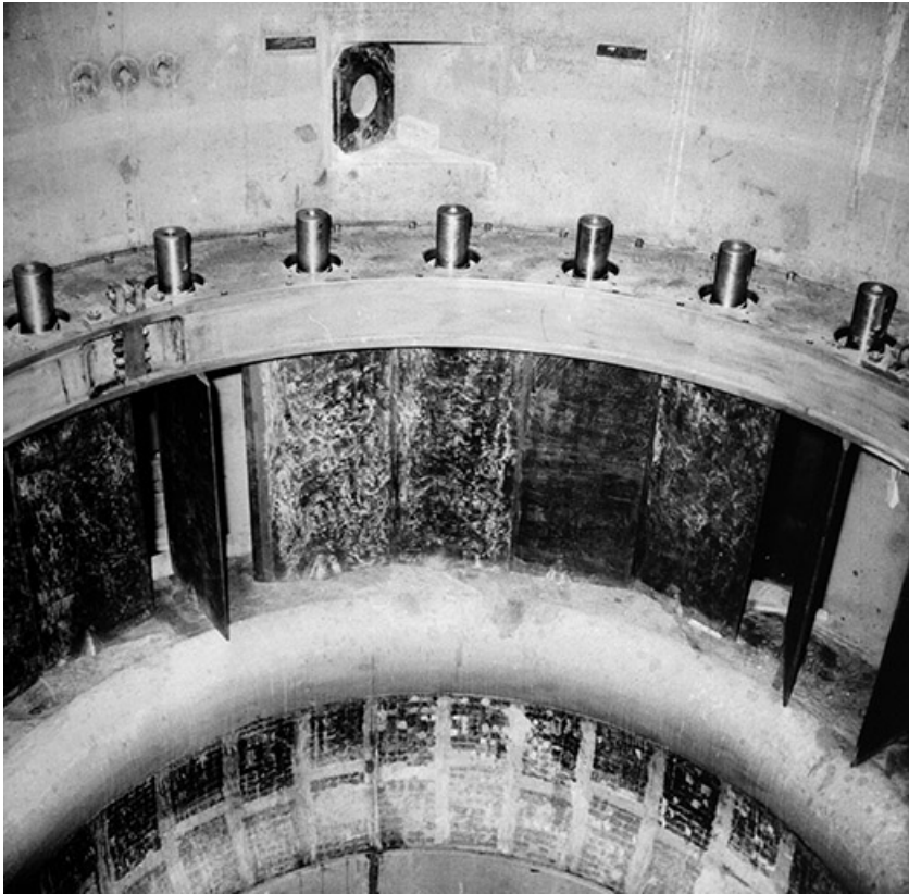
Turbine G.1 : distributeur en cours de montage.
