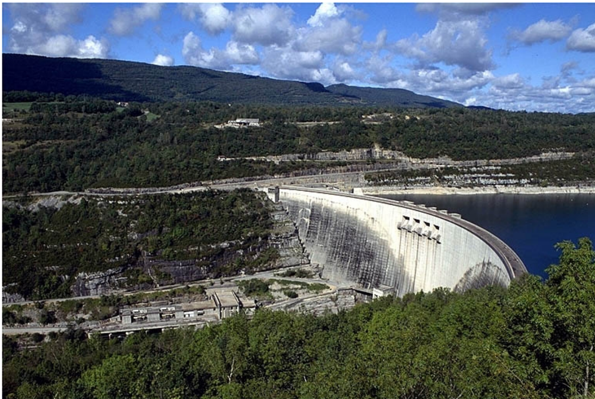
Vue d'ensemble du barrage et de sa centrale hydroélectrique.
