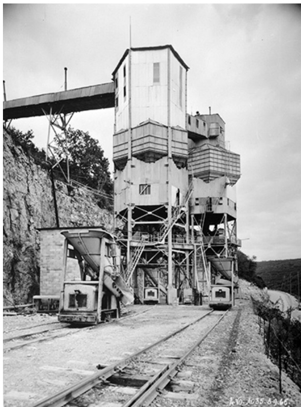
Tour à béton et silobus.
