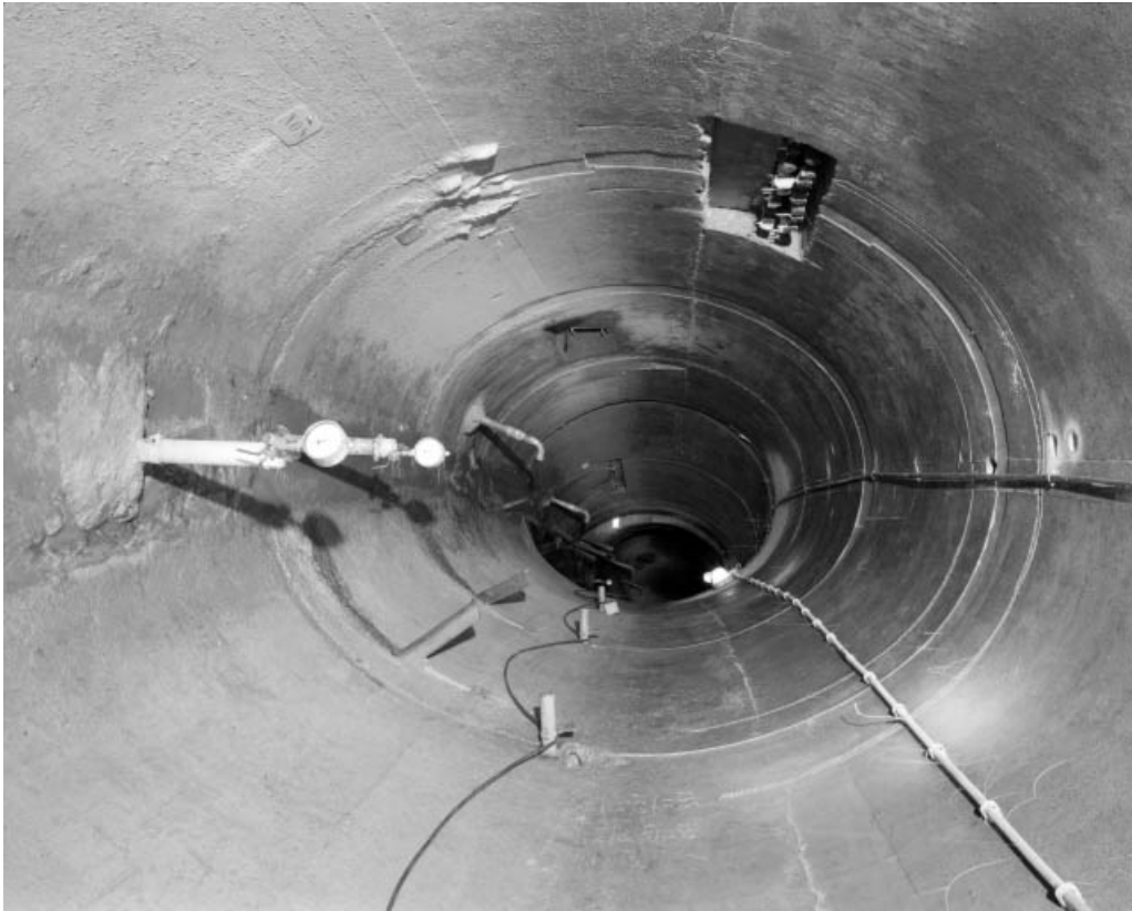
Système d'auscultation du barrage : réseaux piézométrique et de drainage.
