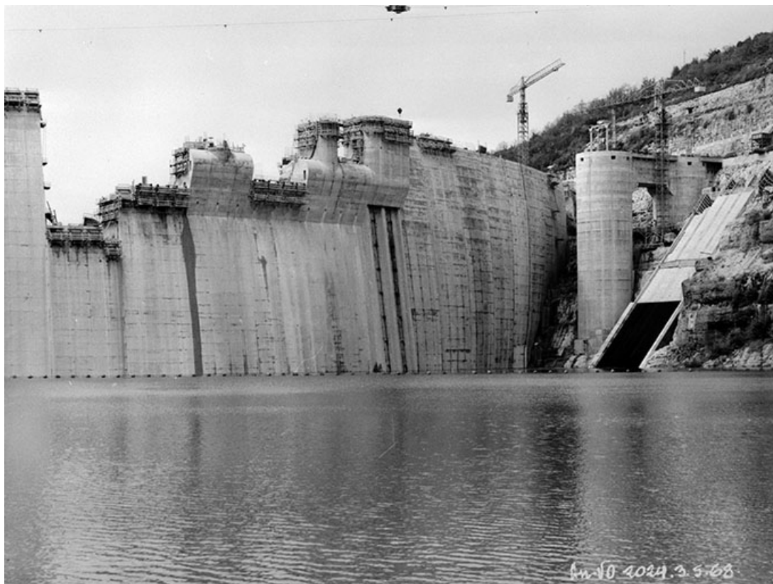
Barrage - Vue amont déversoir et prise d'eau.
