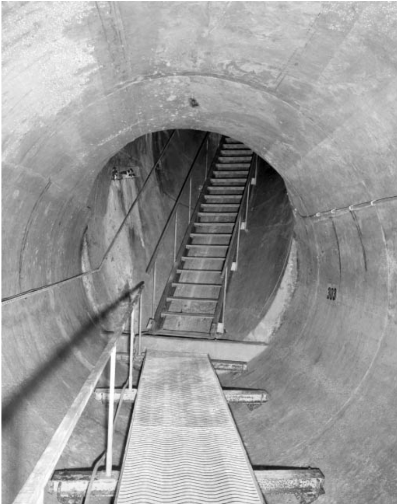
Extrémité inférieure de la "galerie de pied".
