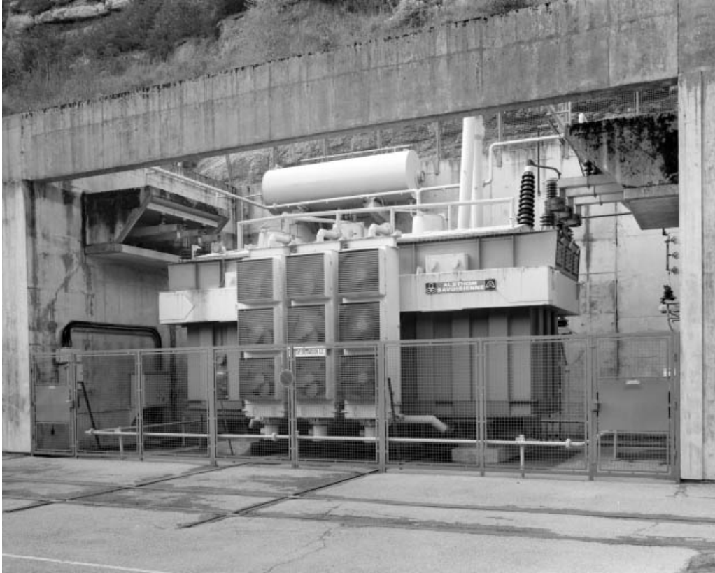
Transformateur Alsthom de 160 MVA.
