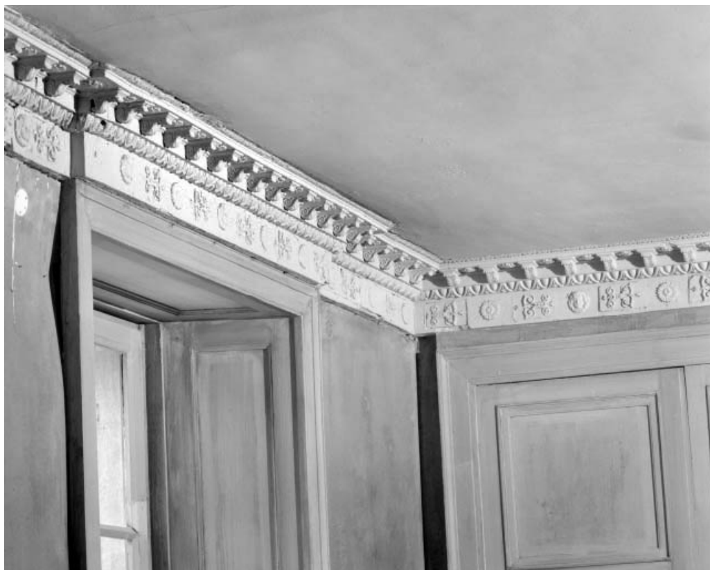
Intérieur de l'habitation : salon, détail de la frise, à l'angle sud-ouest.
