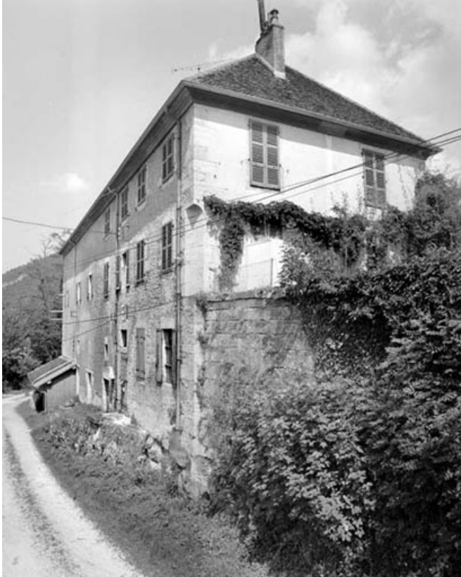
Bâtiment des communs : façade postérieure de trois quarts droit. 39, Syam 1ère demeure d'industriel, lieudit : les Forges
