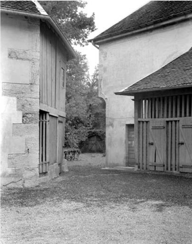
Vue de la cour de service depuis la cour des communs.
