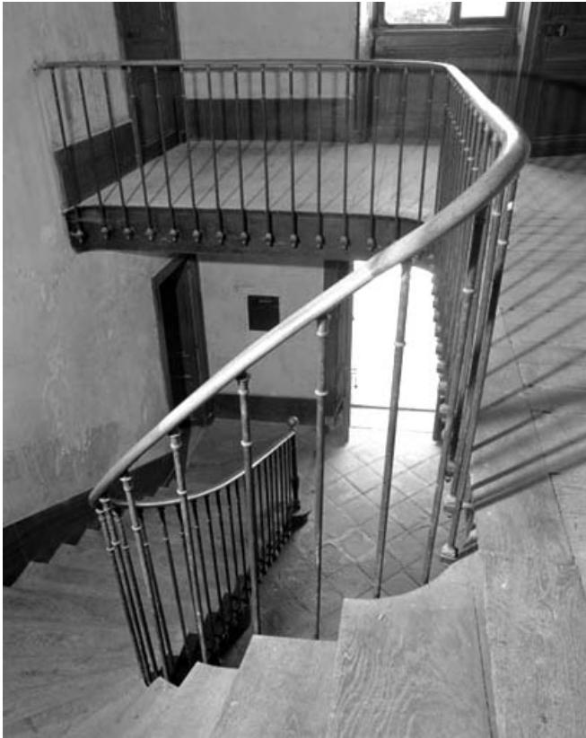
Intérieur de l'habitation : vue d'ensemble de l'escalier principal.
