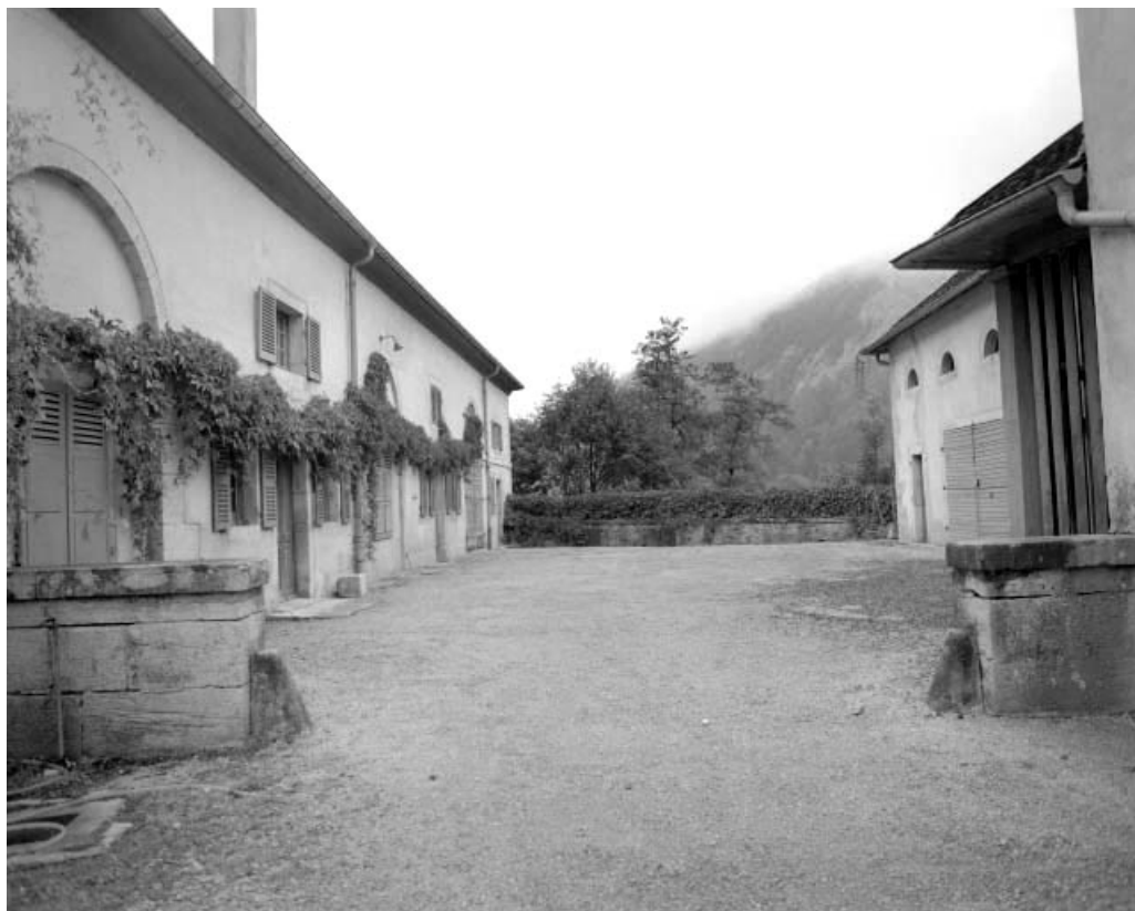
Vue des bâtiments situés de part et d'autre de la cour des communs.
