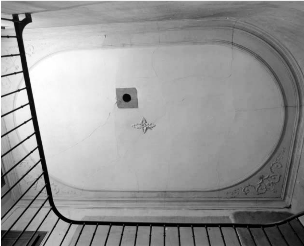
Intérieur de l'habitation : vue du plafond de la cage d'escalier principale.
