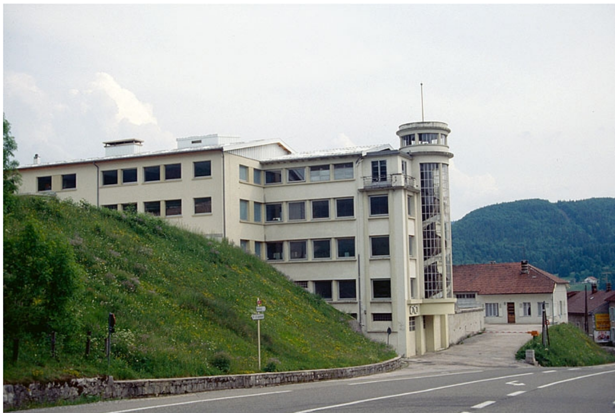
Façade latérale de l'aile nord et cage d'escalier demi-hors-oeuvre.
