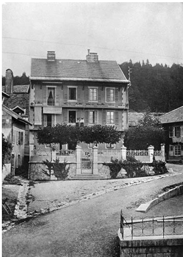
Façade antérieure du logement patronal.
