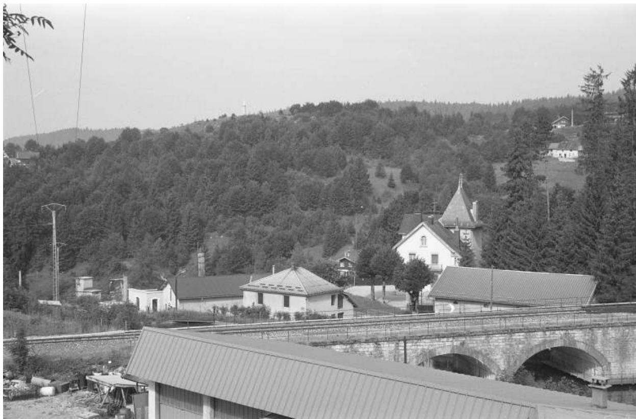
Vue d'ensemble depuis l'est. 39, Morbier, 138 route Blanche
