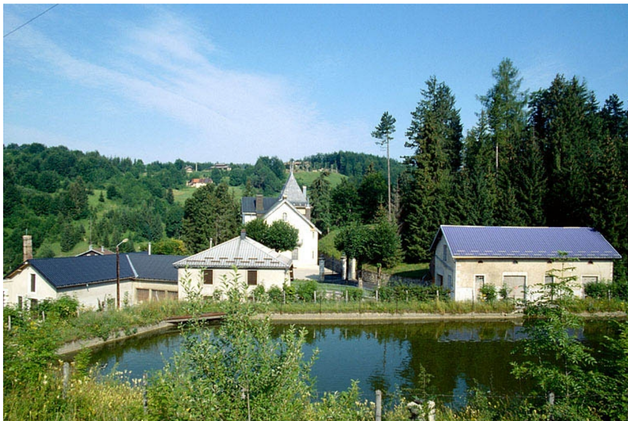
Bassin de retenue et façades sur rue.
