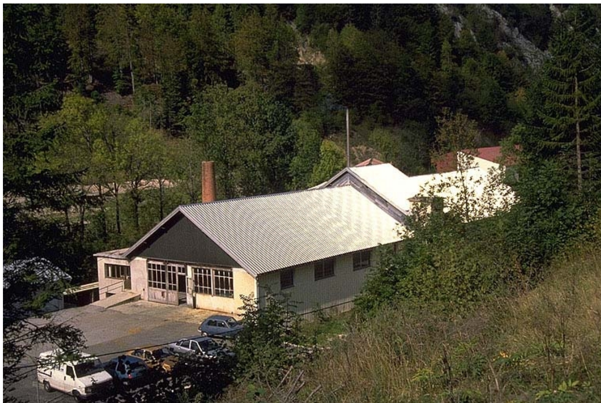
Vue plongeante sur la façade antérieure.
