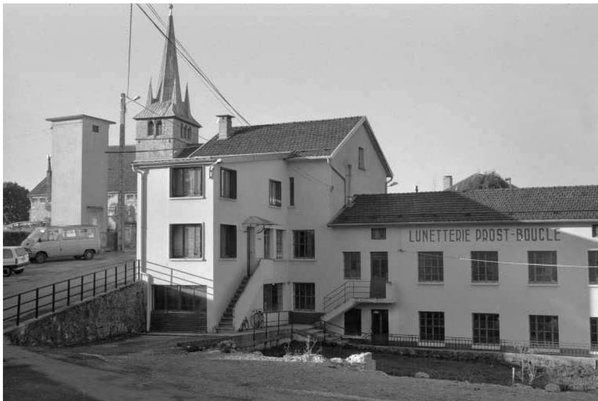
Bureau, atelier de réparation et atelier de fabrication.
