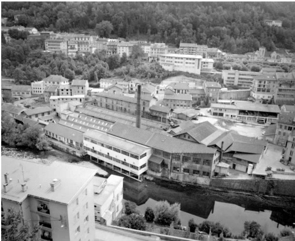
Vue d'ensemble plongeante depuis le nord-ouest. 39, Saint-Claude, 2 à 8 rue du Faubourg des Moulins
