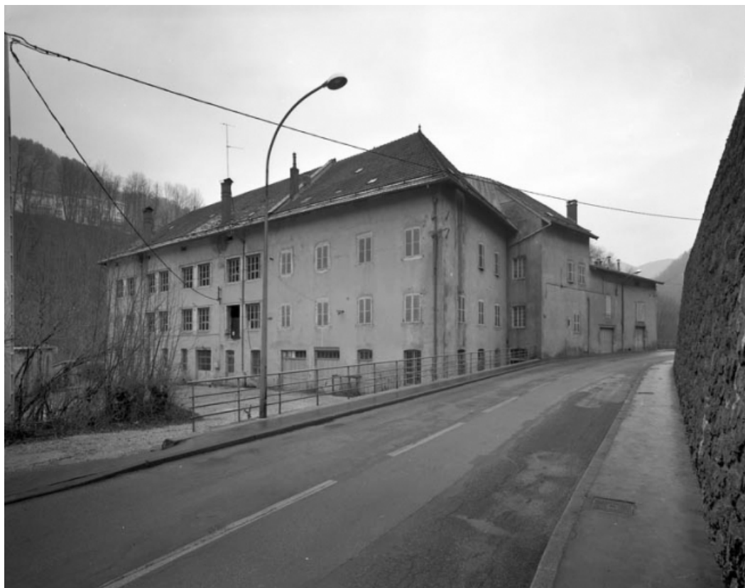
Façade antérieure de l'atelier de fabrication et du logement.
