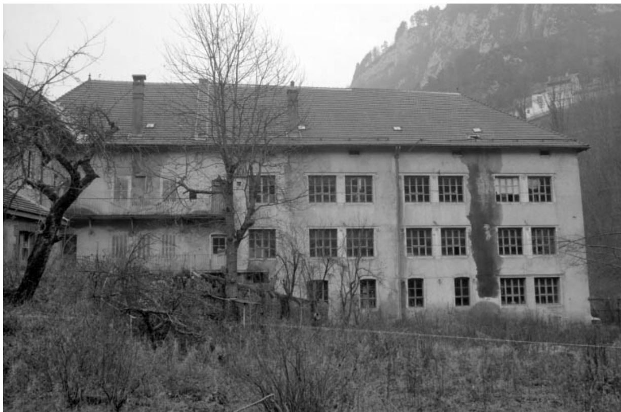
Façade postérieure de l'atelier de fabrication.
