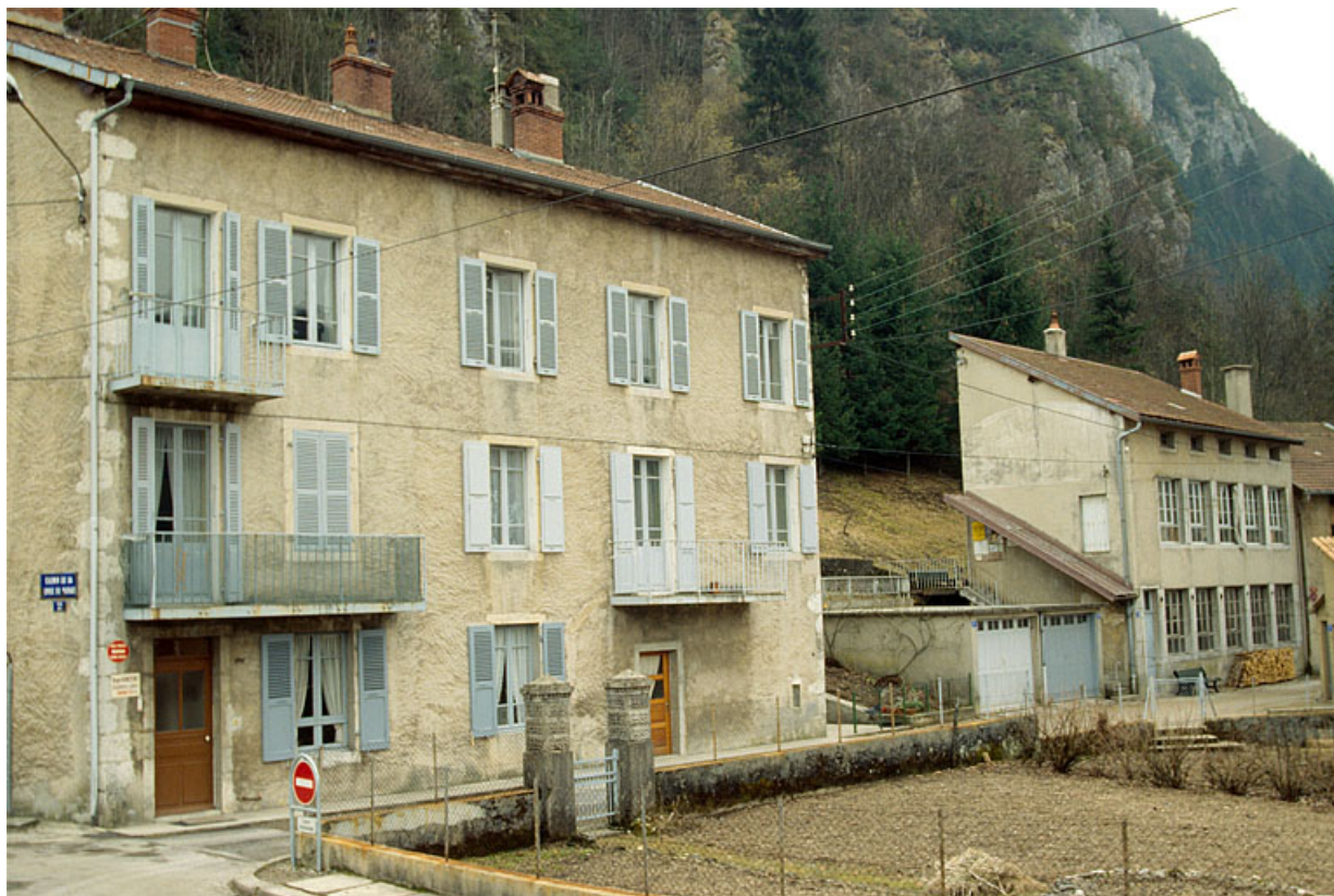
Vue d'ensemble des bâtiments chemin de la Combe du Marais, depuis le nord. 39, Saint-Claude, 2 chemin de la Combe du Marais
