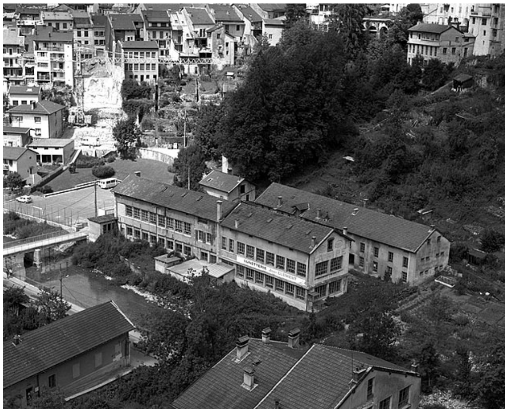
Vue d'ensemble plongeante depuis le sud-est.
