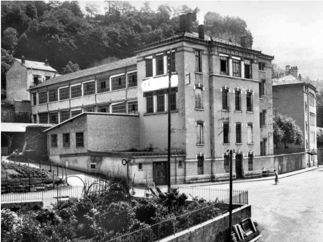
Vue d'ensemble des bâtiments de trois quarts gauche, milieu 20e siècle.
