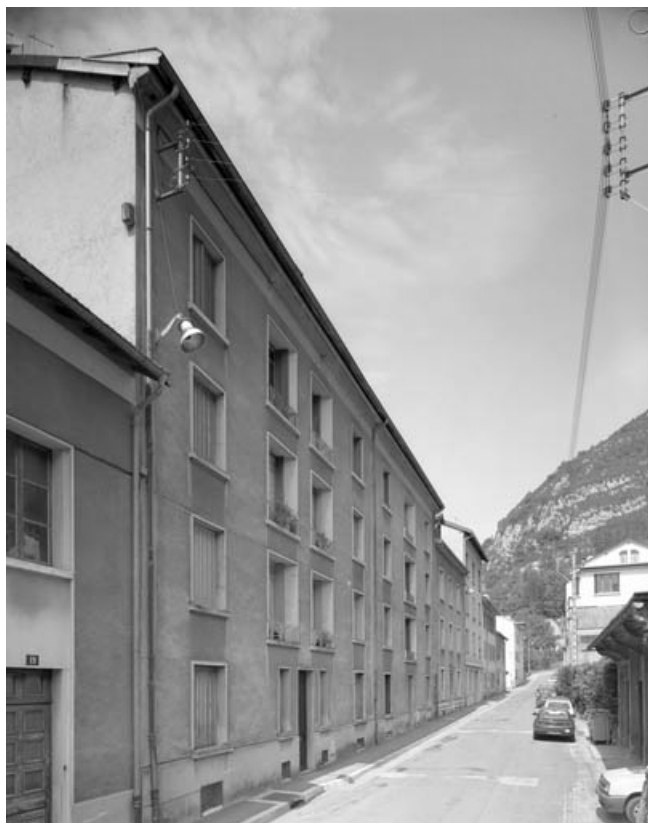
Façade antérieure de l'immeuble aux 15-17, rue Lançon.
