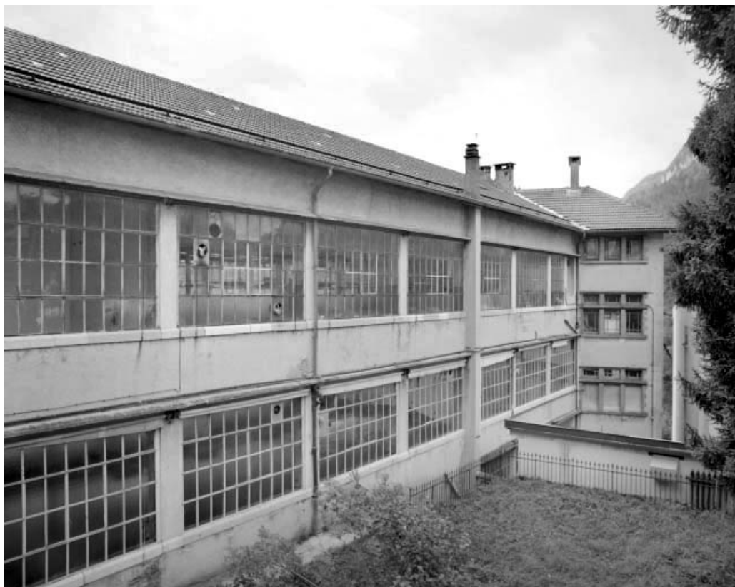
Façade latérale gauche du 2e bâtiment.
